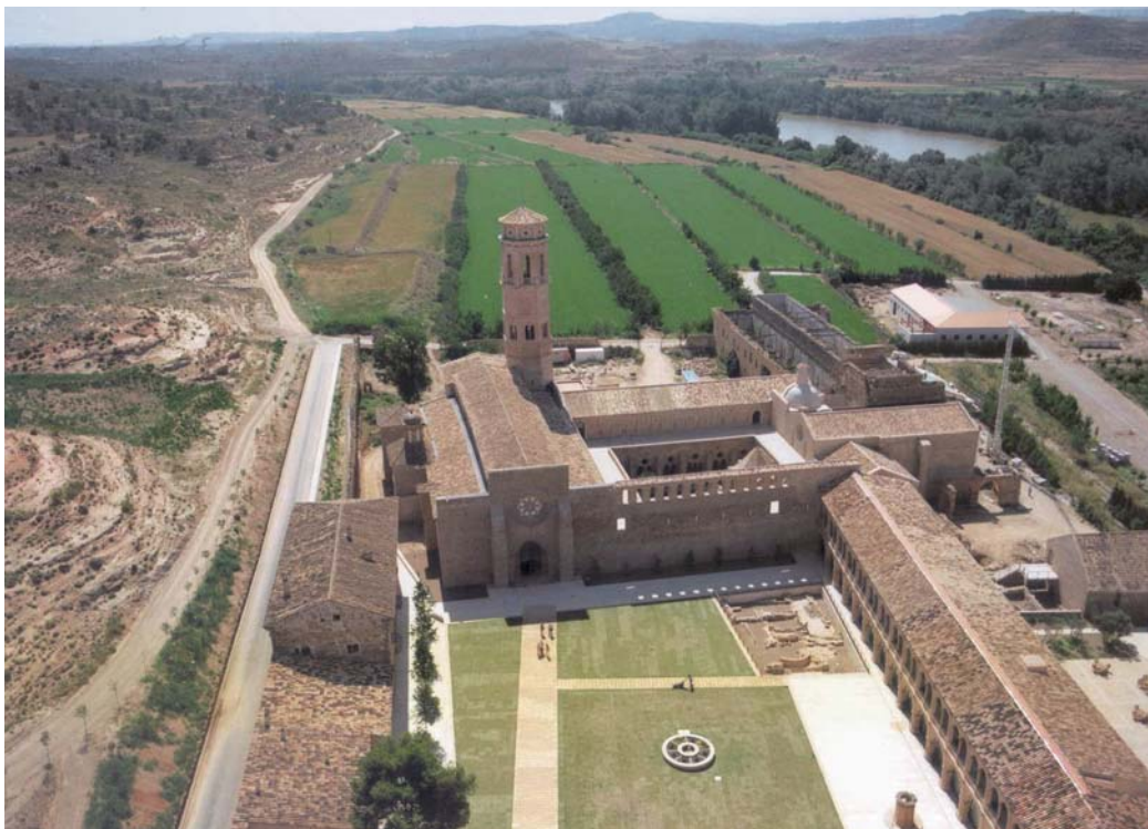
Vista de la iglesia del monasterio desde suroeste
