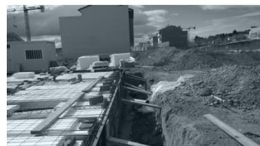
Figura 42. Proceso constructivo: Ejecución del forjado sanitario. Fuente: CRUX Arquitectos.
