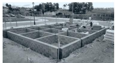
Figura 40. Proceso constructivo: Muretes de hormigón. Fuente: CRUX Arquitectos.
