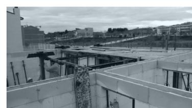
Figura 45. Proceso constructivo: Estructura de muros YTONG. Fuente: CRUX Arquitectos.
