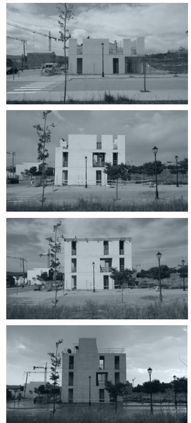
**Figura 47.** Proceso constructivo: Repetición de operaciones en cada nivel hasta finalizar la estructura. Fuente: *CRUX Arquitectos*.
