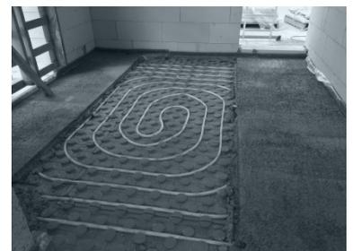
Figura 48. Proceso constructivo: Solados interiores. Fuente: CRUX Arquitectos.
