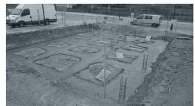
Figura 39. Proceso constructivo: Cimentación superficial. Fuente: CRUX Arquitectos.
