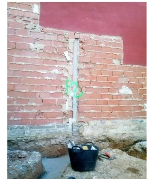
[FIG. 62]- TERCERA VISITA OBRA. EXCAVACIÓN DE ZANJAS PARA LA CIMENTACIÓN. FUENTE: ELABORACIÓN PROPIA
