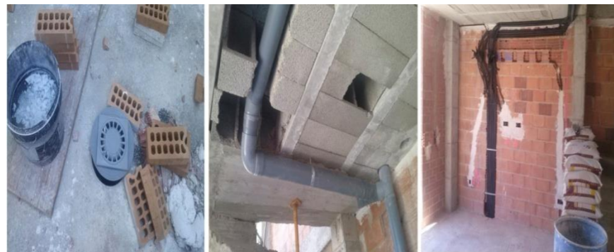
[FIG. 77]- SEXTA VISITA OBRA.COLOCACIÓN DE SUMIDERO EN PATIO INTERIOR . FUENTE: ELABORACIÓN PROPIA
