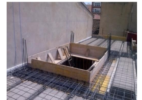
[FIG.71 ]- QUINTA VISITA OBRA.COLOCACIÓN DEL ENCOFRADO DE ESCALERA Y APUNTALAMIENTO. FUENTE: ELABORACIÓN PROPIA
