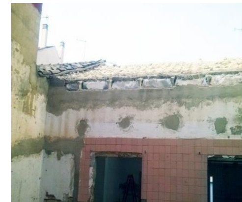
[FIG. 55]- PRIMERA VISITA OBRA. FACHADA PATIO INTERIOR VIVIENDA PREEXISTENTE. FUENTE: ELABORACIÓN PROPIA
