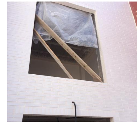
[Fig. 81]- SÉPTIMA VISITA OBRA. COLOCACIÓN LADRILLOS MACIZOS Blancos EN LA FACHADA VENTILADA DEL PATIO INTERIOR. FUENTE: ELABORACIÓN PROPIA
