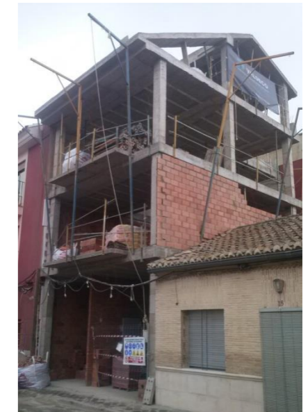
[FIG. 75]- SEXTA VISITA OBRA.CREACIÓN DE FORJADO TERCERO, CUBIERTA CON LOSA MACIZA Y VOLADIZOS PARA LOS BALCONES . FUENTE: ELABORACIÓN PROPIA
