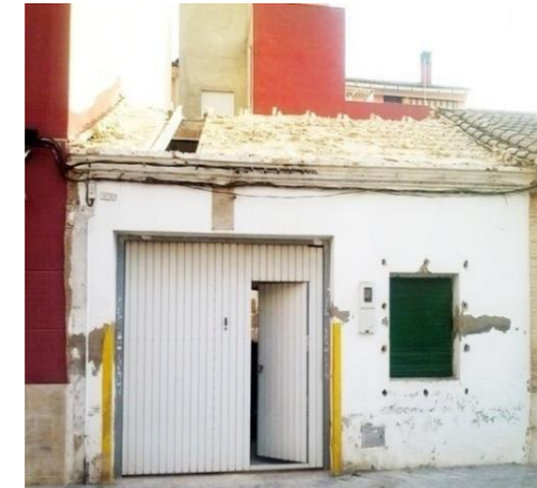
[FIG. 54]- PRIMERA VISITA OBRA. FACHADA PRINCIPAL VIVIENDA PREEXISTENTE. FUENTE: ELABORACIÓN PROPIA
