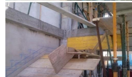
[FIG.70 ]- QUINTA VISITA OBRA.COLOCACIÓN DE ARMADURAS DE VIGAS Y ZUNCHOS EN FORJADO SEGUNDO. FUENTE: ELABORACIÓN PROPIA
