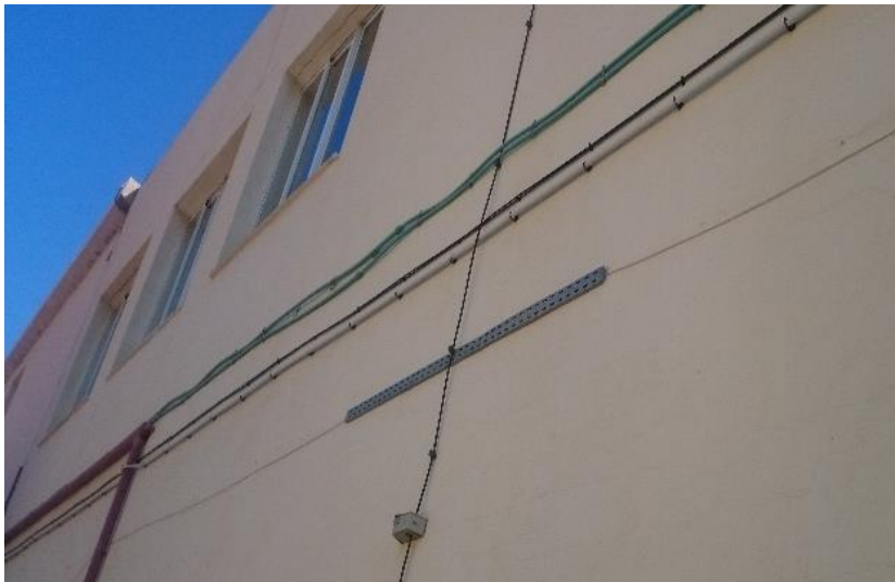
Figura 6-5: Sistema de distribución calefacción
