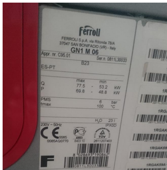
Figura 6-3: Imagen del modelo de la caldera de gasóleo
