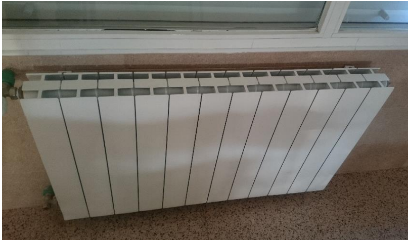
Figura 6-7: Radiador de 12 elementos en clase de ESO
