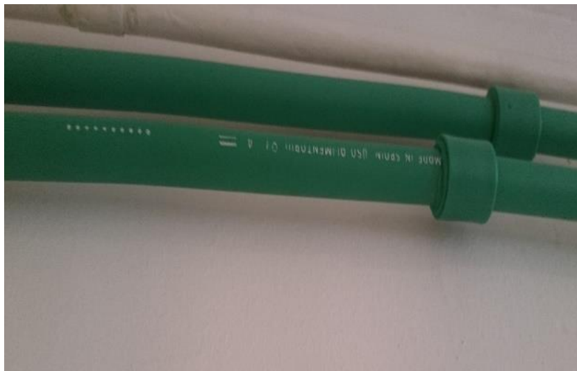
Figura 6-6: Sistema de distribución calefacción 2
