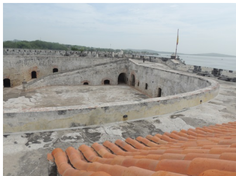
Fig. 6- Vista actual del patio y rampa del fuerte de San Fernando de Bocachica. Foto: J. Galindo.
