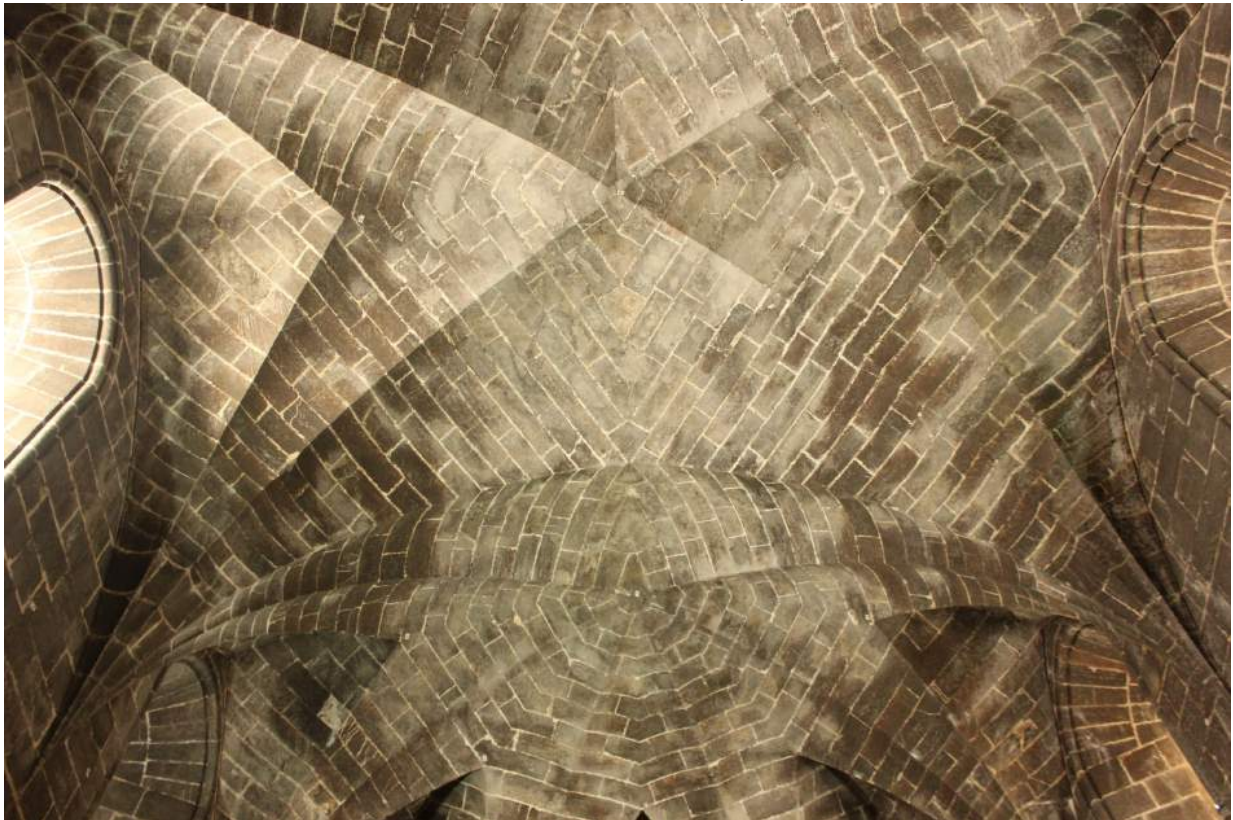
Bóveda aristada de Francesc Baldomar en la Capilla Real. (1439-1463) Foto: Juanjo Ferri
