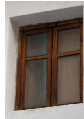
Figura 60: Finestra de proporcions pròpies de la tipologia antiga adaptada per a permetre el pas de la llum. Es podria realitzar deixant el vidre a la part de fora seguint l'ordre de les finestres amb finestrons de la resta del poble o bé deixant la mateixa part a l'interior per a així no alterar l'aparença de finestra cega.
