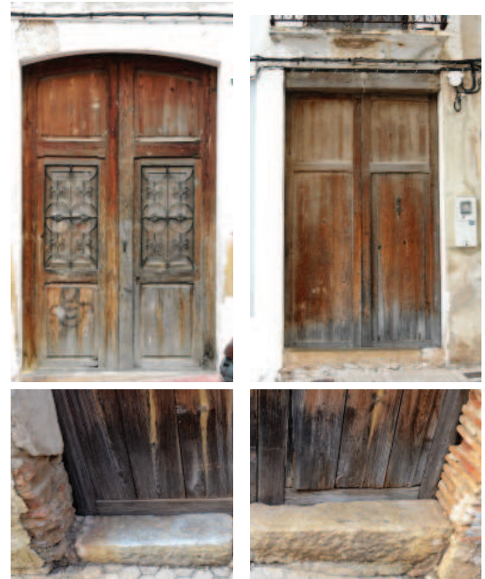
Figura 45: Porta amb dintell de rajola en forma d'arc rebaixat.
