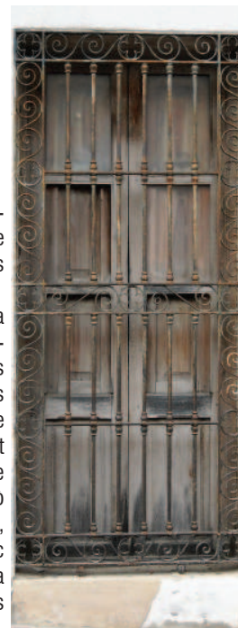
Figura 58: Finestra de vertical amb finestrons i vidrieres.
