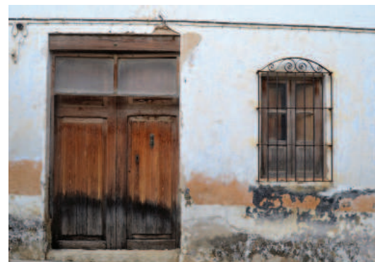
Figura 42: mur de mamposteria.
