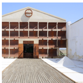
Figura 12: Vista exterior de la fachada.
