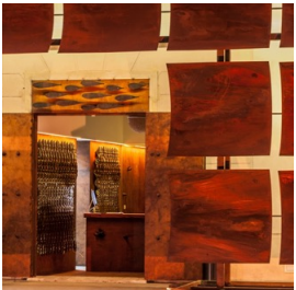
Figura 16: Acceso desde el patio, de acero cortén.
