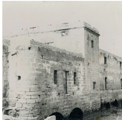
Estado previo molino.
