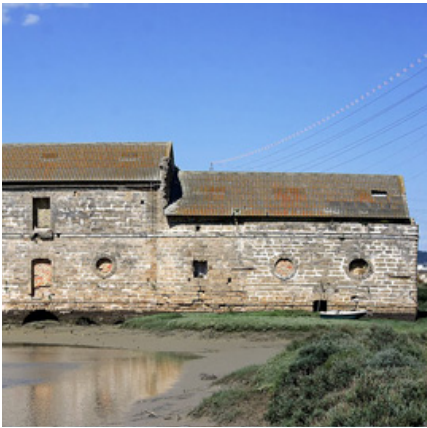
Estado previo molino.
