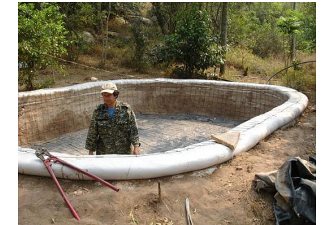
Imatge 14. Fotografia d'execució de piscina en supertova. Font: revista Ecohabitar
