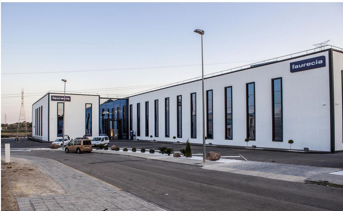
Fig.1: EDIFICIO ACTUAL, ENTRADA PRINCIPAL. Cedido por FAURECIA INTERIOR SYSTEMS
