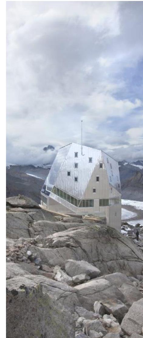
forma de telaraña. Lo que se pretendía era separar la parte inferior del refugio del propio suelo para evitar el calentamiento del permafrost, la capa de hielo permanente superficial.
