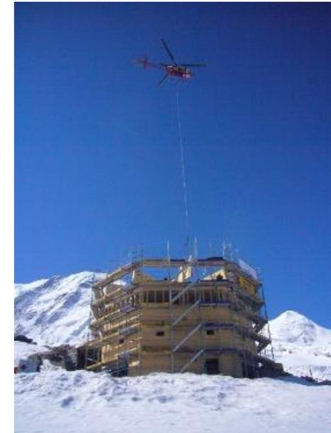
Figura 45. Depósito de material del helicóptero en fase avanzada de la obra.
