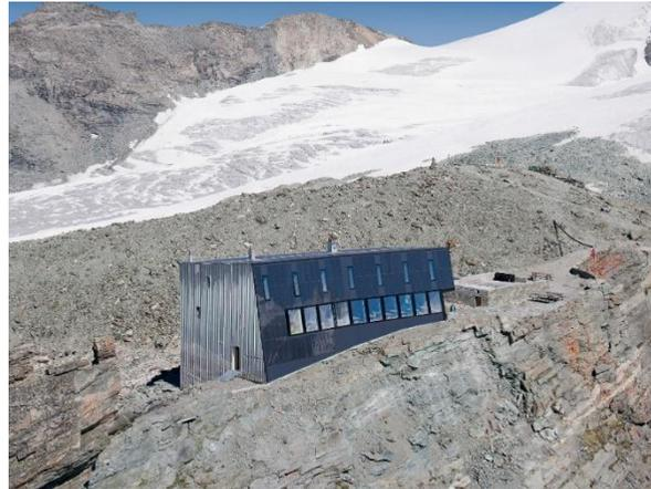
Las fachadas y la cubierta se cubrieron con paneles corrugados de inox, escogido por su cualidad anticorrosiva. El acero inoxidable permite igualmente recuperar el agua de la cubierta apta para el consumo gracias a su estabilidad química. Las fachadas quedan así revestidas con planchas que reflejan distorsionadamente el paisaje que envuelve al refugio, permitiéndole fundirse en su entorno.
