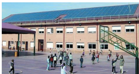
Fig. 30 – Sistema fotovoltaico en un centro docente Fuente: Guía de ahorro y eficiencia energética en centros docentes Fenercom
