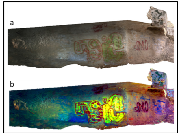
Figura 2: a) Textura original; b) Decorrelation Stretching (algoritmo LDS).
