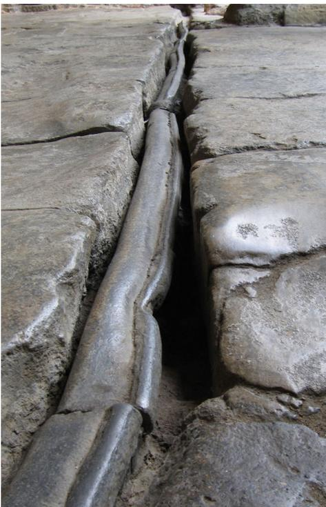
Figura 29. Tubería de plomo romano de suministro de agua del Baño principal en los Baños Romanos.
