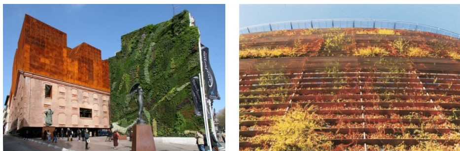
Figura 3.1. (Izquierda) [Edificio CaixaForum, Madrid (España)]. (Derecha) [Edificio consorcio, Santiago (Chile)].
