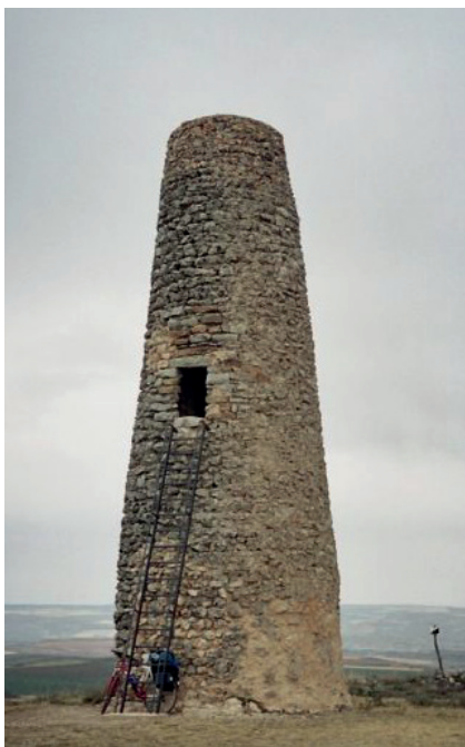
Fig. 15. Atalaya de Tiñón de Almanzón. Rello, Soria. Según cuenta la leyenda, esta milenaria atalaya troncocónica de 9 metros de altura y 5 de diámetro, sirvió de lecho de muerte al caudillo árabe Almanzor, cuando se retiraba malherido hacia sus aposentos en Medinaceli después de ser derrotado en la batalla de Calatañazor.
