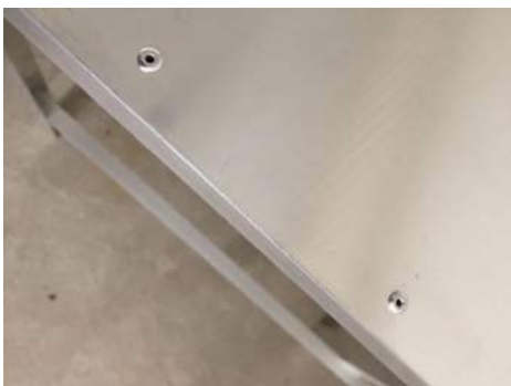
Figura 28. Detalle del remachado de la mesa.
