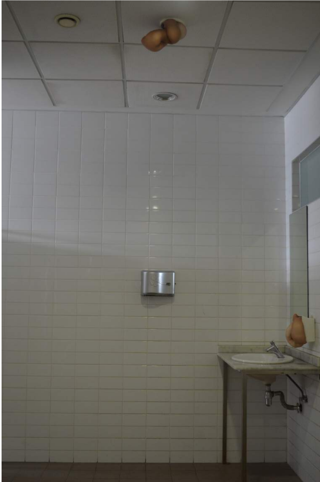
Figura 47. Imagen general de la parte derecha del hall de los servicios.
