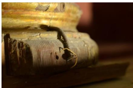
Figura 29. Clavo de forja
