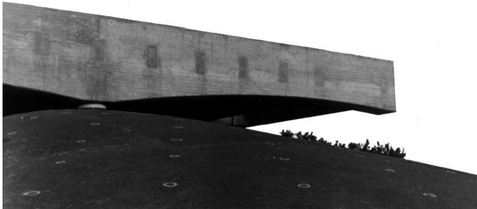
6. Imagen del pabellón construido.
