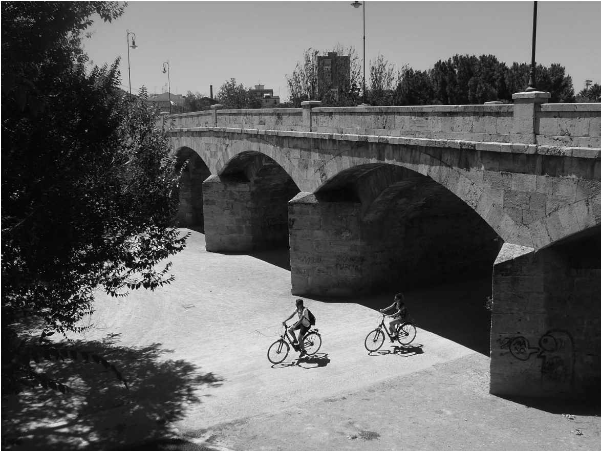
F11- PUENTE DE SAN JOSÉ
