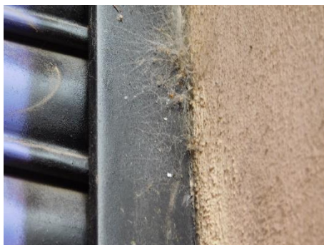
Fig. 24 y 25.: Arriba, laguna dejando el metal visible. Abajo, ejemplo de la presencia de telarañas.
