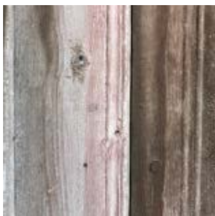
Figura 8. Fotografías de detalle de la madera puerta.
