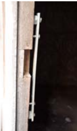
Figura 18. Elemento añadido de refuerzo.
