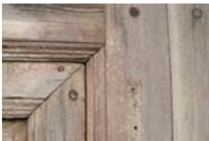
Figura 9. Fotografías detalle de clavo metálico y clavijas de madera.
