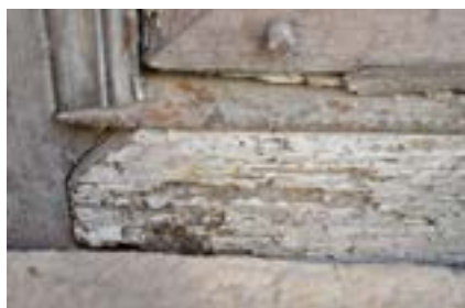
Figura 25. Travesaño inferior izquierdo atacado por insectos xilófagos.
