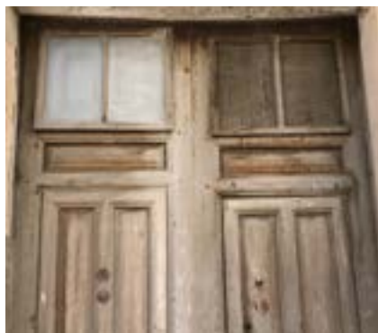
Figura 15. Ejemplo de rejilla que se conserva en otra casa de una calle cercana.
