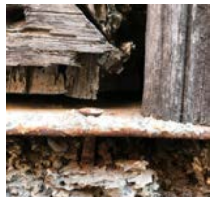
Figura 10. Fotografías en secuencia de aproximación al tornillo que une la lámina metálica inferior izquierda con el travesaño.
