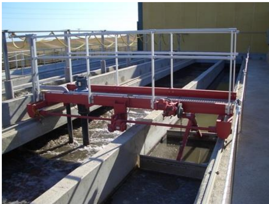
Figura 6. Puente desarenado desengrasado longitudinal.
