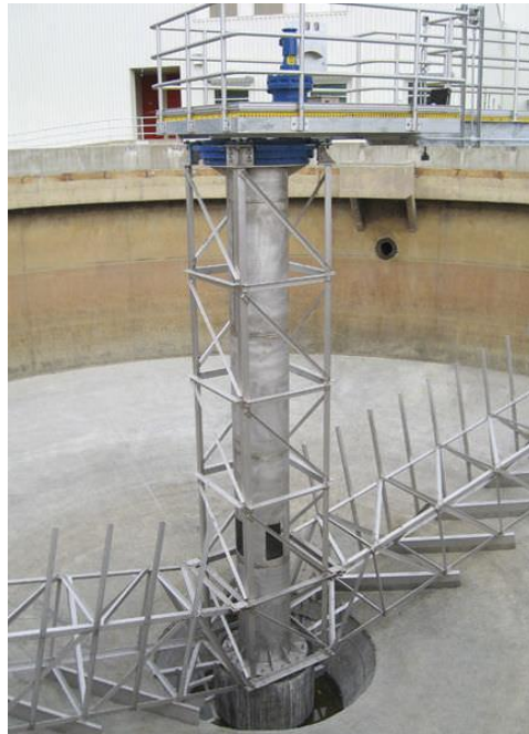
Figura 13. Espesador de fangos.
