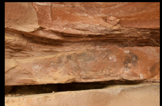
Fig.107. Delaminación y eflorescencias salinas de la roca.
