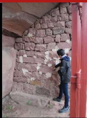
Fig. 67. Toma de mediciones de las dimensiones del abrigo.
