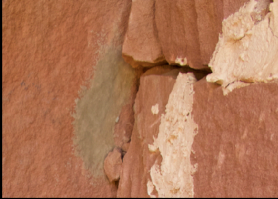
Fig.118. Muro de mampostería y cemento en el panel.
