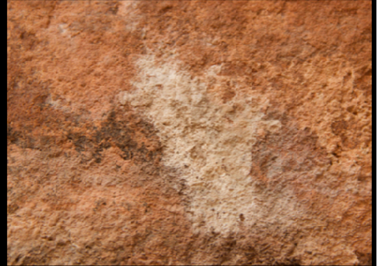
Fig.115. Eflorescencia salina.
