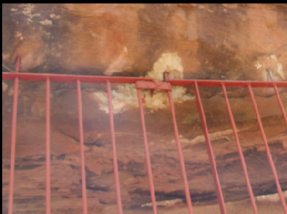
Fig. 121. Unión de la verja del cerramiento con la techumbre del abrigo.
