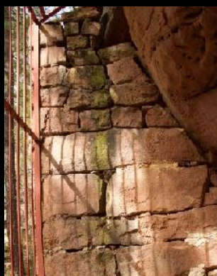
Fig.75. Muro de cerramiento del lateral izquierdo.
