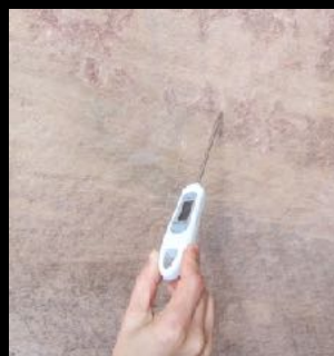
Fig.78. Medición de la temperatura de superficie.
