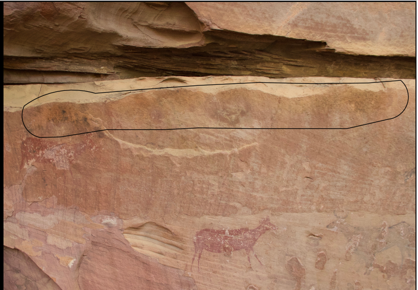
Fig. 73. Humedad por agua de lluvia con viento en el panel.
