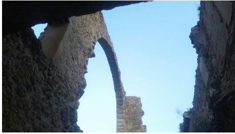
Fig. 5. Interior de la capilla.
