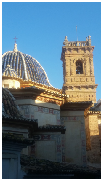
Fig. 14. Cúpula y campanario de la iglesia de San Roque.
