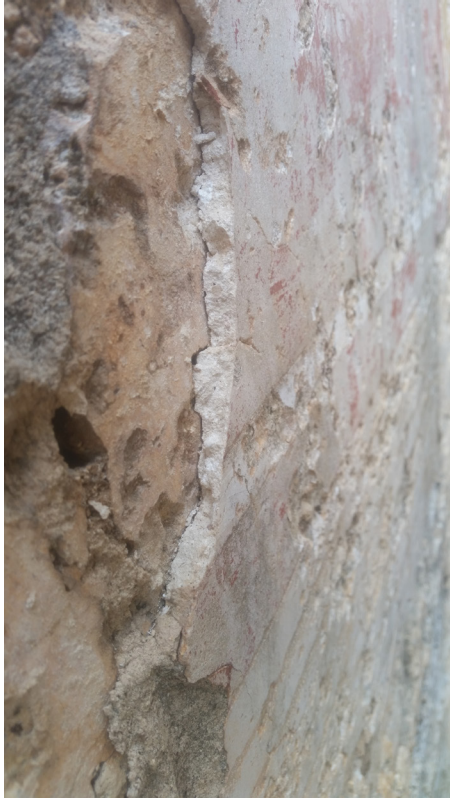
Fig. 11. Detalle de las capas de preparación.
