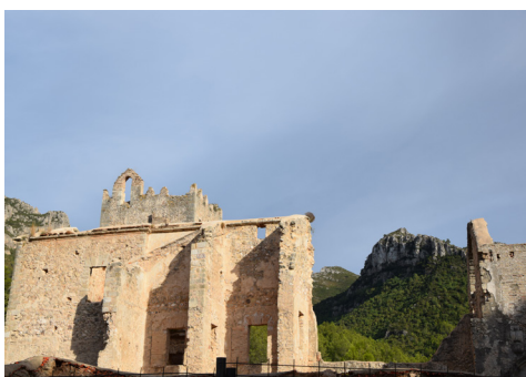
Fig. 25. Estructura principal del monasterio.
