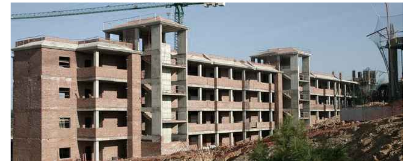
[Fig.27]: VIVIENDAS DE PROTECCIÓN OFICIAL EN CONSTRUCCIÓN.
