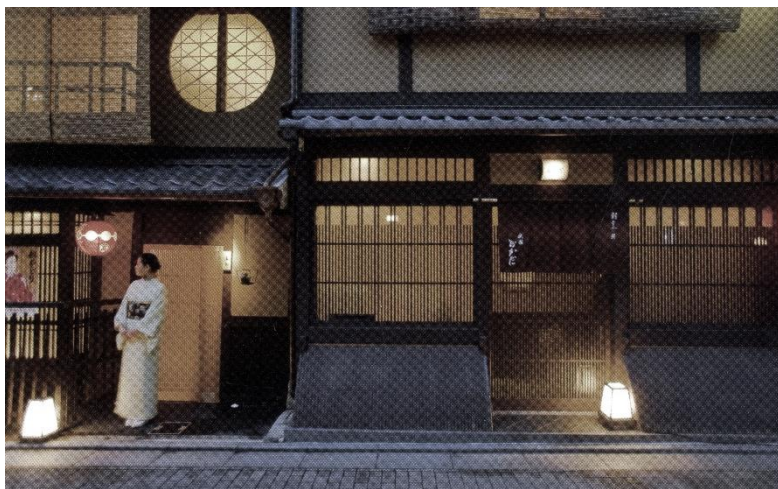
Imagen 5.1: Fachadas con diferentes diseños de celosías en puertas y ventanas y tiras de bambú en la parte interior de la fachada usadas para protegerlas. Fuente: (Locher 2010, 47)
