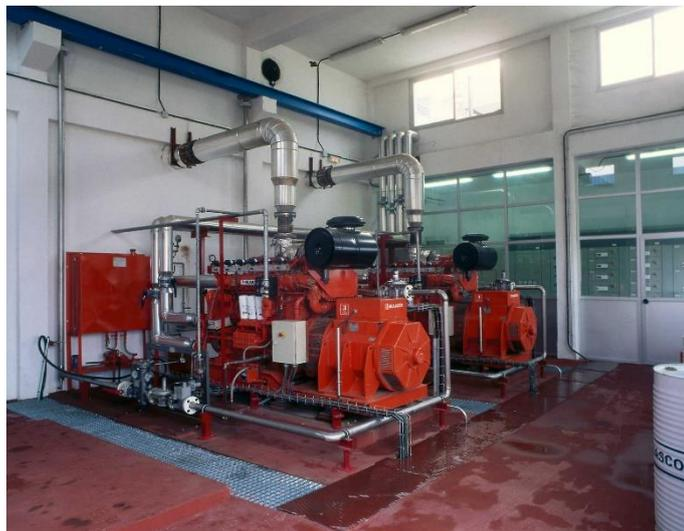
*Imagen. 1.11. Cogeneradores de biogás utilizados para transformar el biogás en energía eléctrica.*
