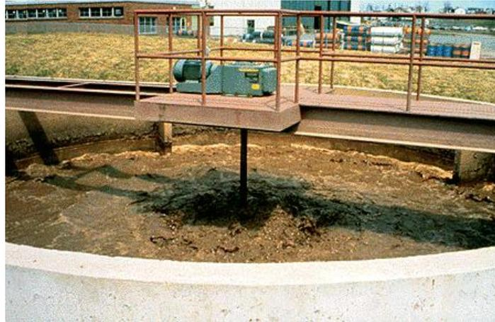
*Imagen 1.9. Digestor aerobio, donde el licor mezcla es aireado y está en movimiento.*
