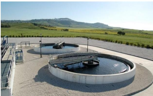
Imagen 1.5. Decantadores donde se lleva a cabo el tratamiento físico químico del agua residual urbana a tratar.
