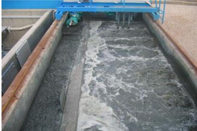
Imagen 1.4. Arenador desengrasador encargado de separar grasas y arenas del agua residual urbana.
