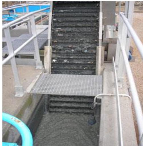
*Imagen 1.3. Tamizado del agua residual.*
