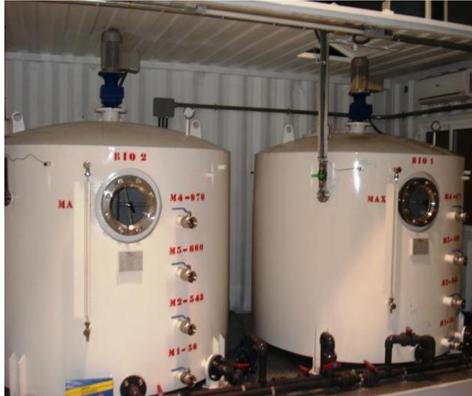
*Imagen 1.10. Digestores anaerobios, con tanques herméticos y entradas y salidas de fangos y de gases.*
