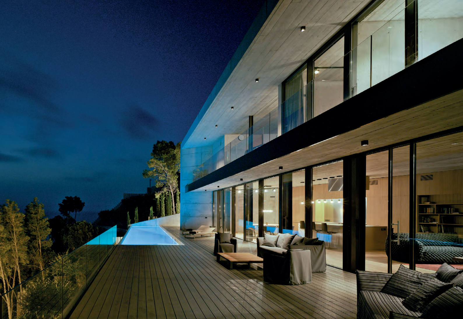
Figura 2. Fachada NE: Vista nocturna. Archivo Singular Studio (2016). ©David Frutos / Figure 2. NE façade: night view. Singular Studio's archive (2016). ©David Frutos.
