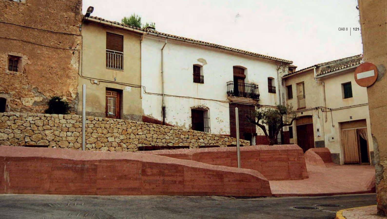
Figura 4. Vista general de la actuación (2000) / Figure 4. General view of the intervention (2000).
