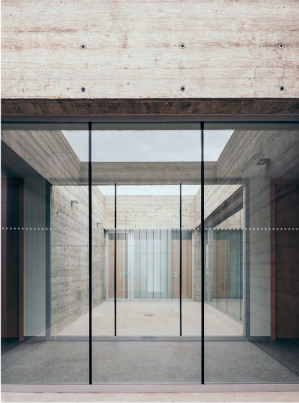
Figuras 9 (página anterior) y 10. Diferentes texturas del hormigón en los muros exteriores e interiores. ©Javier Bravo / Figures 9 (previous page) and 10. Different concrete textures on the external and internal walls. ©Javier Bravo.
