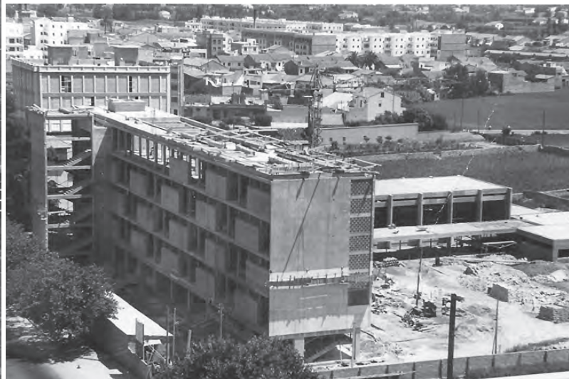
Figura 13. Vista aérea del conjunto en obras (1960). Archivo Fam. Navarro Esteve / Figure 13. Aerial view of the set in works (1960). Archive Fam. Navarro Esteve.
