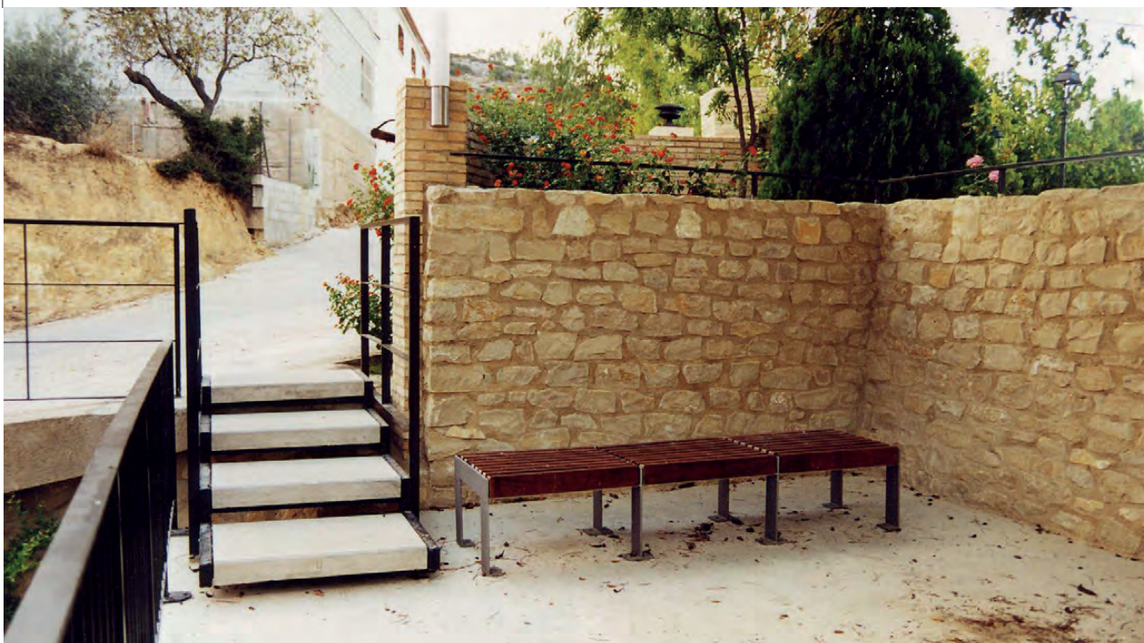
Figura 9. Plataforma elevada en su conexión con la escalera hacia el nivel inferior (2000) / Figure 9. Upper platform and stairway to lower level (2000).
