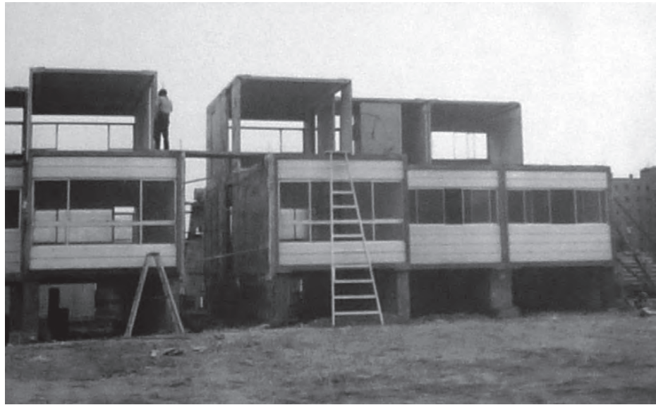
Figura 7. Proceso de montaje de las dos plantas, Fernando Martínez García-Ordoñez (1968), SIC Proceso investigativo. Memoria final. Archivo Fundación March / Figure 7. Assembly process of the two plants, Fernando Martínez García-Ordoñez (1968), SIC Investigation process. Final Memories. Fundación March Archive.
