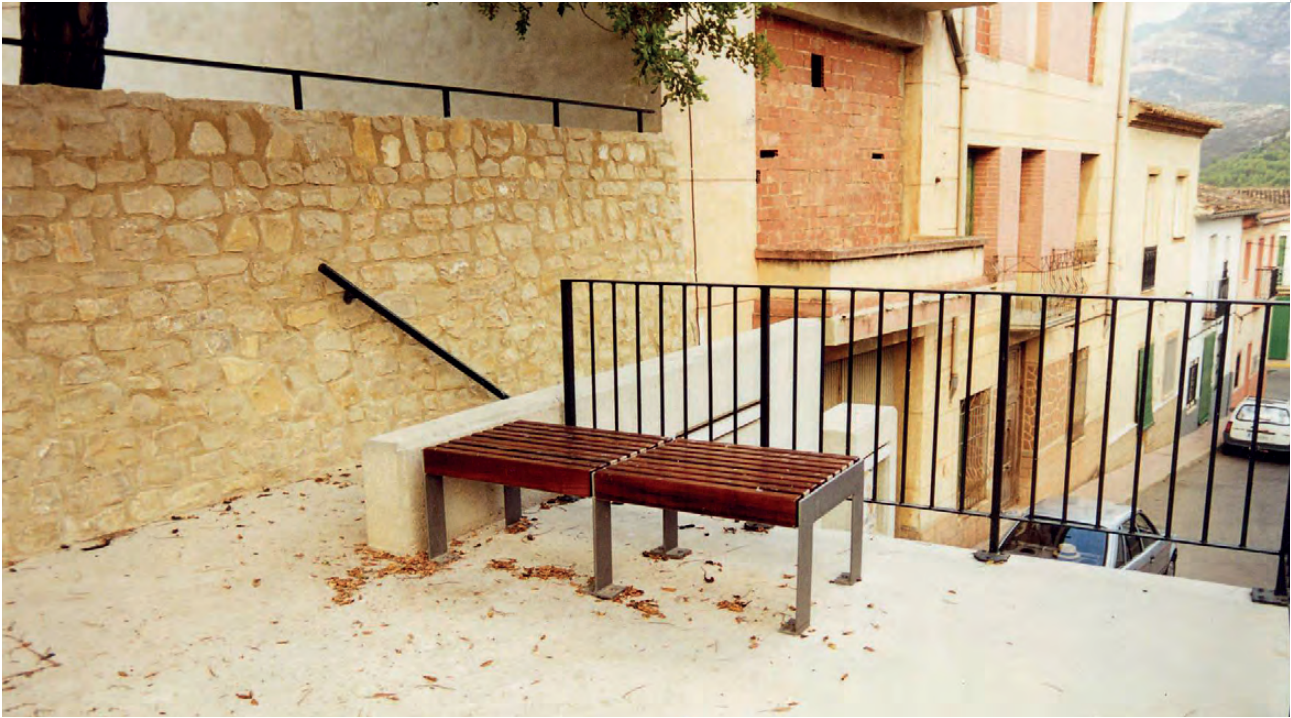
Figura 10. Plataforma elevada en su conexión con la escalera hacia el nivel inferior (2000) / Figure 10. Upper platform and stairway to lower level (2000).
