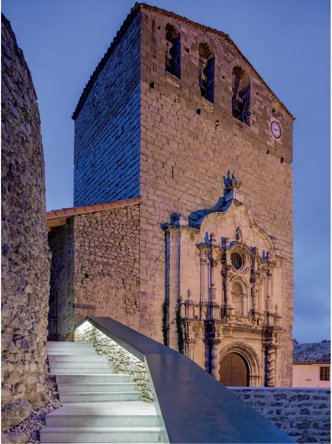
Figura 7. Campanario desde nuevo acceso (2014). ©Milena Villalba fotografía de arquitectura / Figure 7. View of the church tower from the new entrance (2014). ©Milena Villalba photographer.
