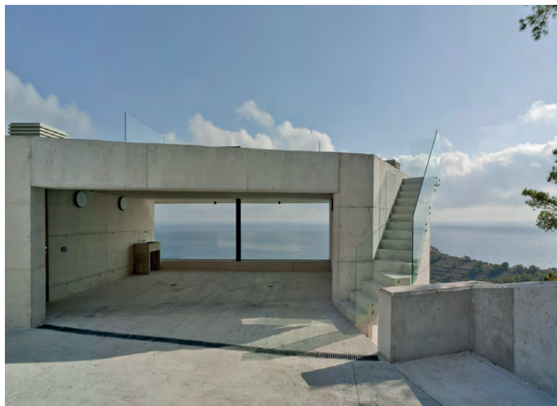
Figura 9. Fachada exterior: acceso garaje. Archivo Singular Studio (2016). ©David Frutos / Figure 9. Exterior façade: garage access. Singular Studio's archive (2016). ©David Frutos.
