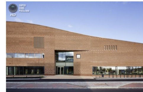
50. Acceso Oeste. El edificio tiene un lado trasero que parece un castillo de ladrillo, frente a la calle.
