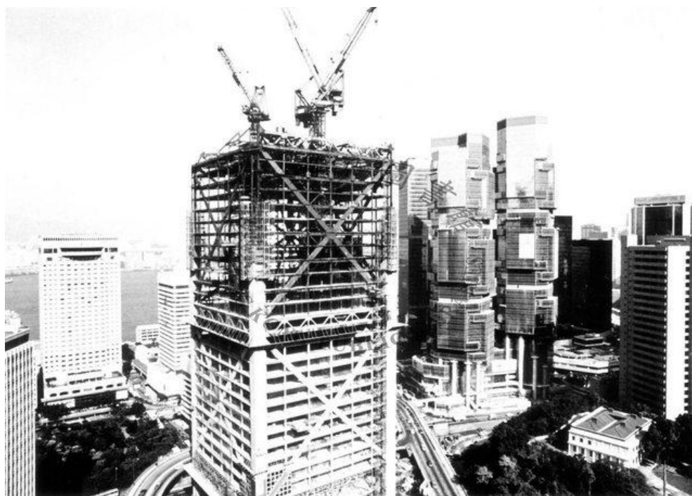
Img 9: Imagen del proceso constructivo. Las obras finalizaron en 1990.
