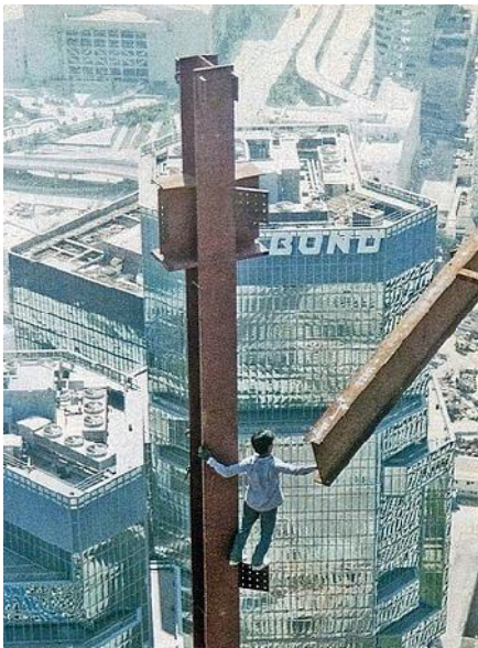
Img 12: Imagen del proceso constructivo
