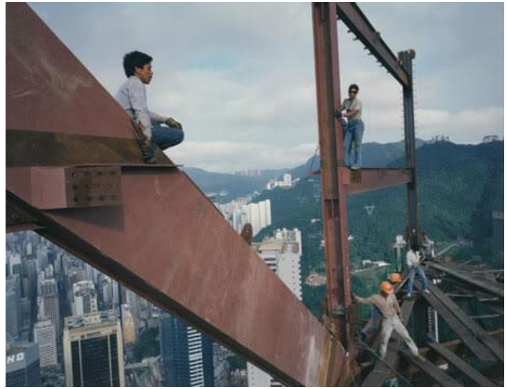
Img 11: Imagen del proceso constructivo
