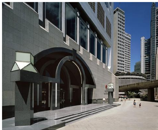
Img 7: Acceso por el macizo de granito
