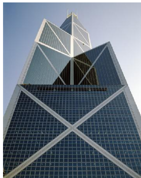
Img 12: Imagen del acristalamiento en altura y paneles anodizados.
