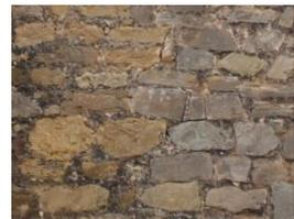
Imagen 39. Diferencia de mampuestos en muro
