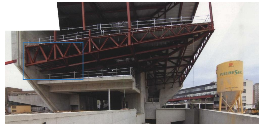
Imagen 3.21 (Sup) Estructura metálica sala principal aún en construcción. Imagen 3.22 (Inf) Estructura metálica inferior sala secundaria.
