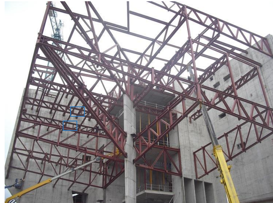
Imagen 3.19 Estructura metálica sala principal.
