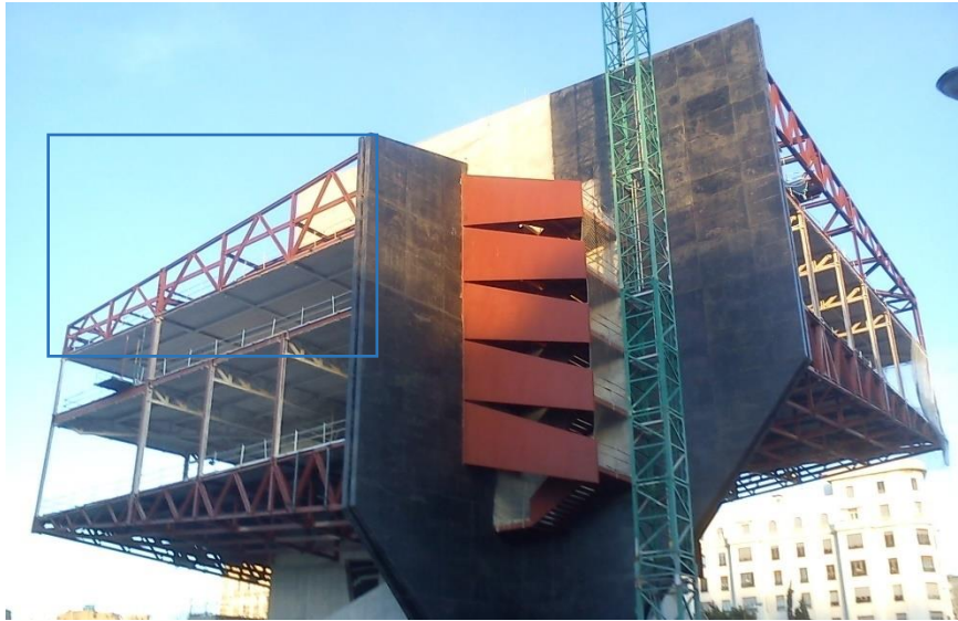
Imagen 3.20 Vista general de la estructura.
