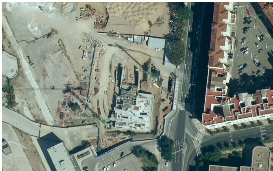
Imagen 2.48 Vista aérea del solar durante la fase inicial de proyecto.
