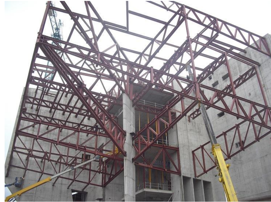
Imagen 2.57 Últimos pasos del proceso constructivo de la estructura metálica.
