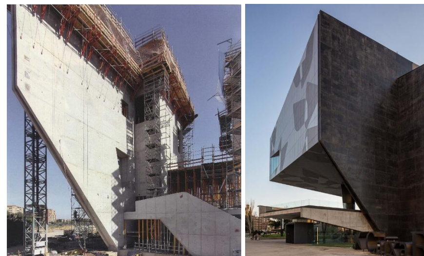
Imagen 2.31 Muro de hormigón durante su construcción. Imagen 2.32 Muro ya acabado.
