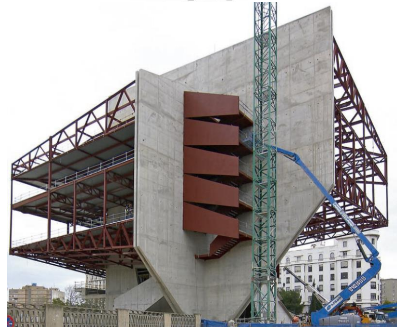
Imagen 3.16 (Sup) e Imagen 3.17 (Inf) Comparativa entre el modelo y la estructura construida.
