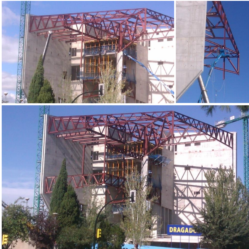
Imagen 2.54 (Sup Izq), 2.55 (Sup Der) e 2.56 (Inf) Proceso constructivo de la estructura metálica.
