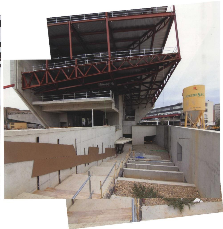
Imagen 2.40 Vista de la estructura desde el jardín exterior del auditorio.
