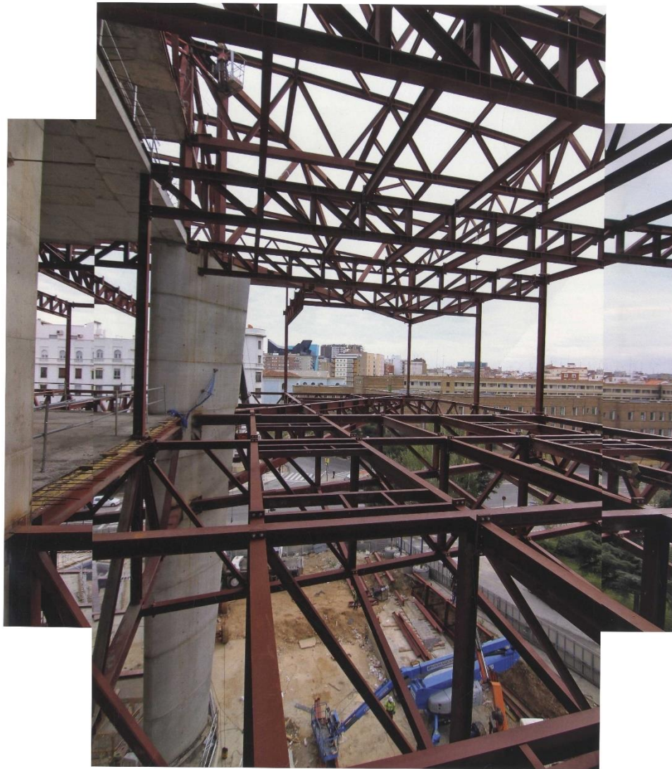
Imagen 2.39 Collage de la estructura vista desde segunda planta.
