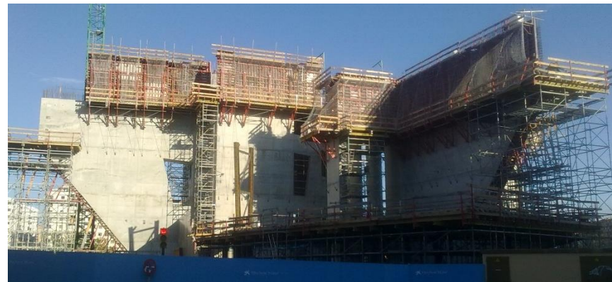
Imagen 2.49 (Sup) e Imagen 2.50 (Inf) Construcción de los elementos estructurales de hormigón.
