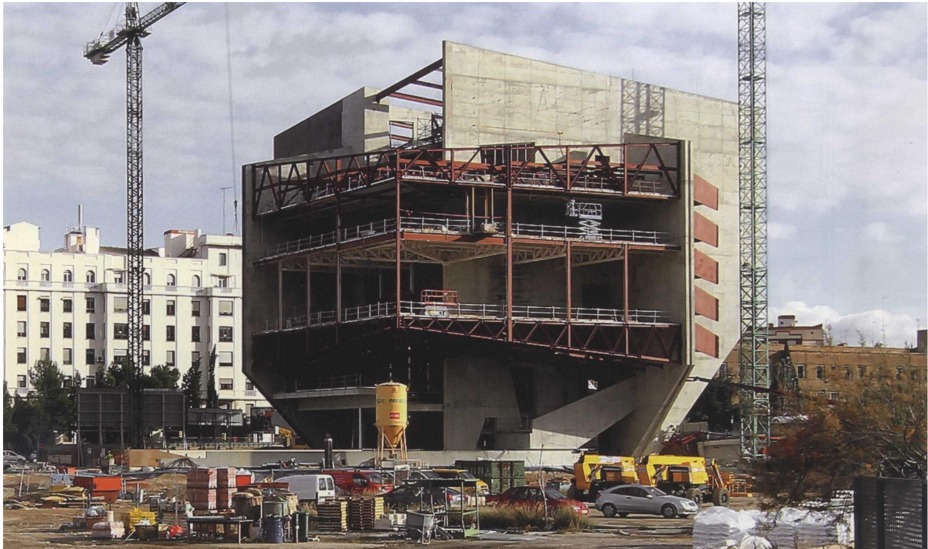
Imagen 2.34 Vista general de la estructura.
