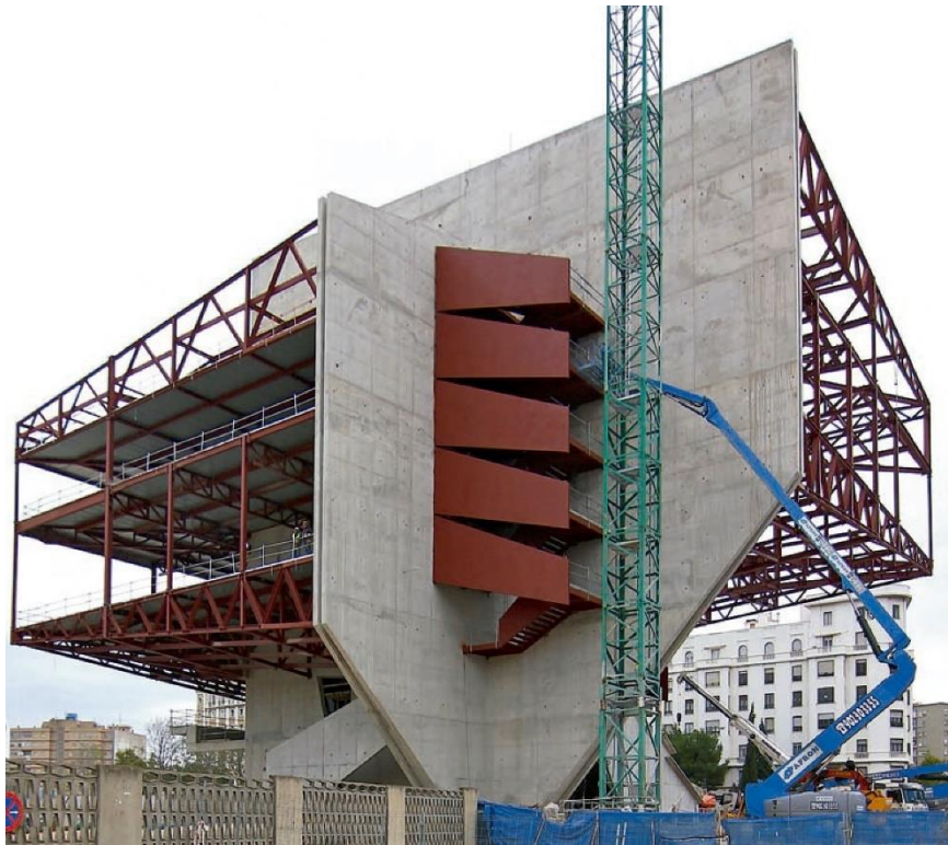
Imagen 2.58 Estructura metálica finalizada, en el volumen izquierdo los forjados ya se han hormigonado, proceso que se realizará a continuación en el otro volumen.
