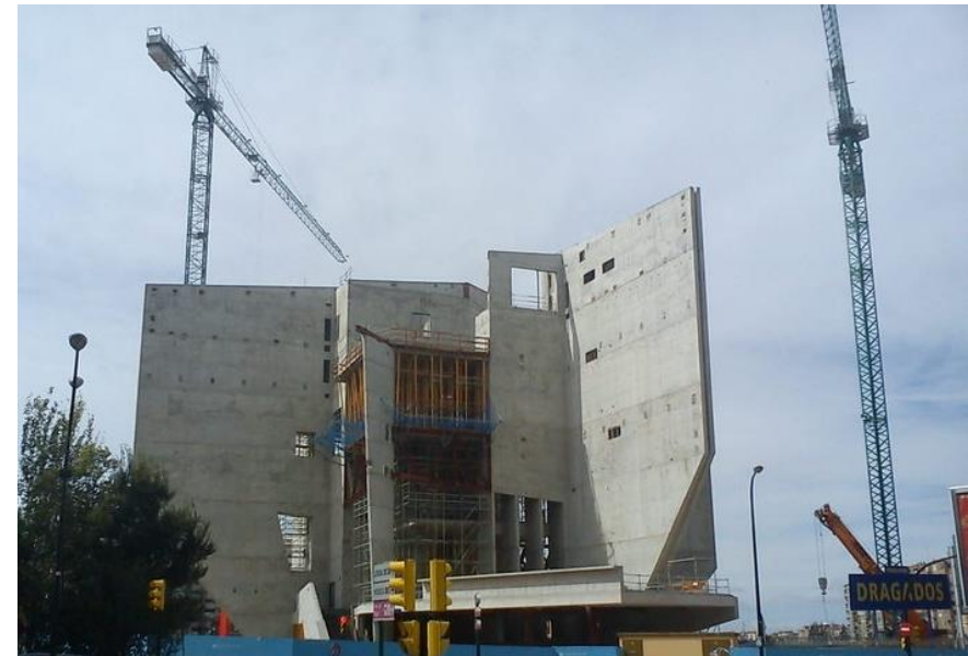
Imagen 2.53 Estructura resistente de hormigón y planta mezzanine finalizadas.
