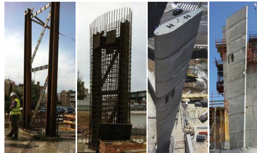
Imagen 2.26 a Imagen 2.29 De izquierda a derecha proceso constructivo del pilar fusiforme.
