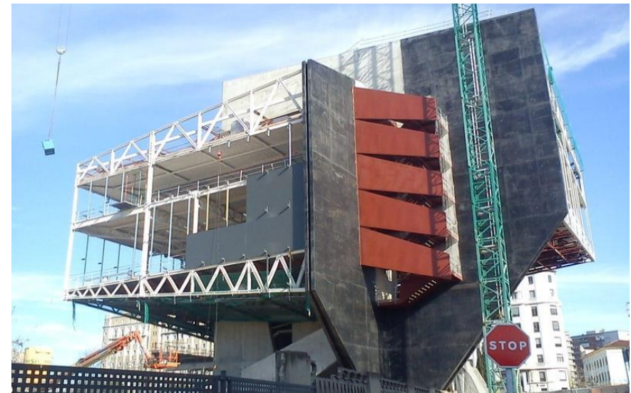
Imagen 2.59 (Sup) Protección de la estructura metálica. Imagen 2.60 (Inf) Colocación de los primeros paneles interiores de fachada y su subestructura, pintado de muros y paso de instalaciones.
