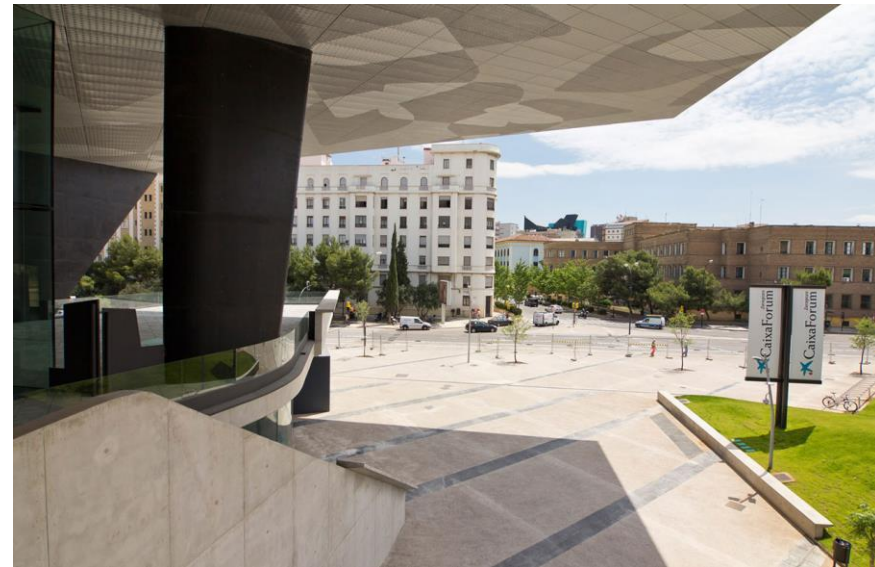
Imagen 5.2 Vista del proyecto a la altura de la planta mezzanine.
