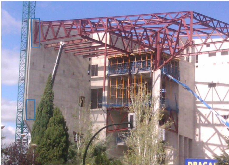
Imagen 3.15 Proceso constructivo de la estructura metálica.
