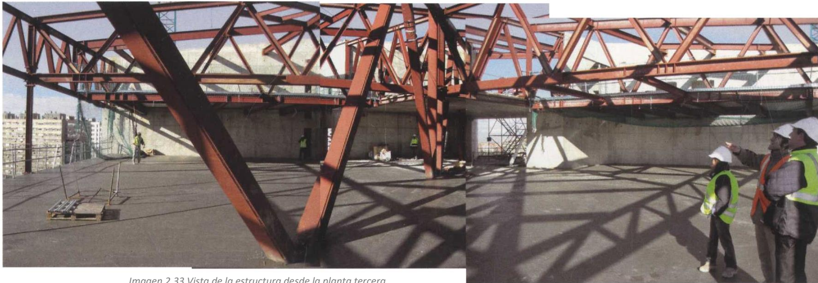
Imagen 2.33 Vista de la estructura desde la planta tercera.
