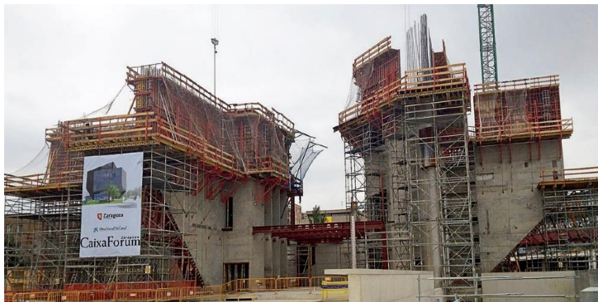
Imagen 2.51 (Sup) Estructura metálica planta mezzanine. Imagen 2.52 (Inf) Construcción de los elementos estructurales de hormigón, vista opuesta.
