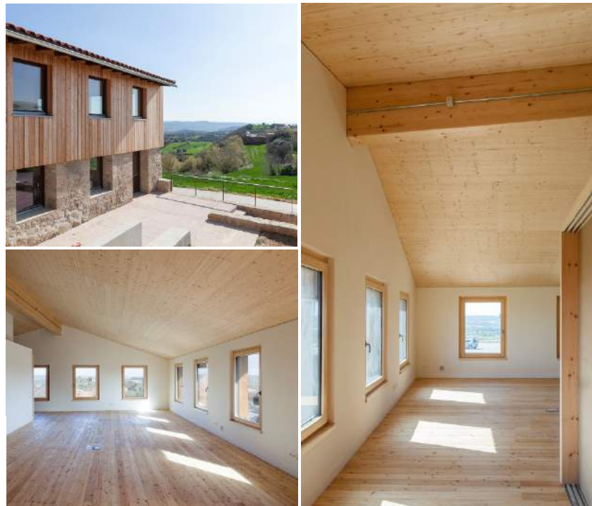
Fig.13. Ampliación de vivienda unifamiliar en Lleida. 2014. Certificada como casa pasiva ( passivhouse ): estructura de abeto laminado certificado, aislantes naturales de fibra de madera y celulosa, carpinterías de madera, cámara ventilada... El consumo en climatización según cálculos realizados no sobrepasa los 15 Kw h /m 2 a tal y como marca el estándar Passivhouse .
