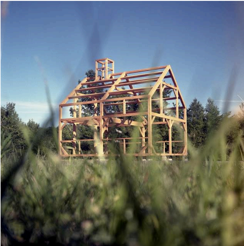
Fig.09. Esqueleto de una estructura pesada de madera formada por soportes y vigas para una vivienda unifamiliar de dos plantas. El sistema se asimila a una estructura porticada formada por elementos de hormigón armado cuya envolvente no cumple ninguna función de transmisión de cargas.
