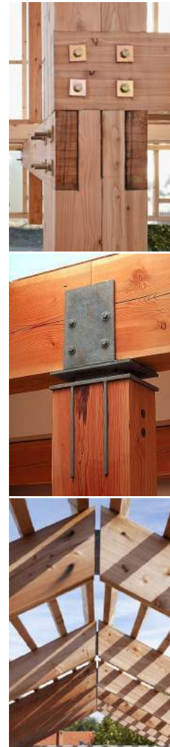
Fig.10. Detalles constructivos reales de diferentes tipos de uniones mecánicas entre viga-pilar y viga-viga de madera. Obsérvese que, en el primer detalle, el diseño de la unión hace se elimina la necesidad de una pieza auxiliar metálica a diferencia de los otros dos detalles siguientes. Las uniones metálicas son los puntos más peligrosos de la estructura en caso de incendio y por lo tanto se han de tomar precauciones.
