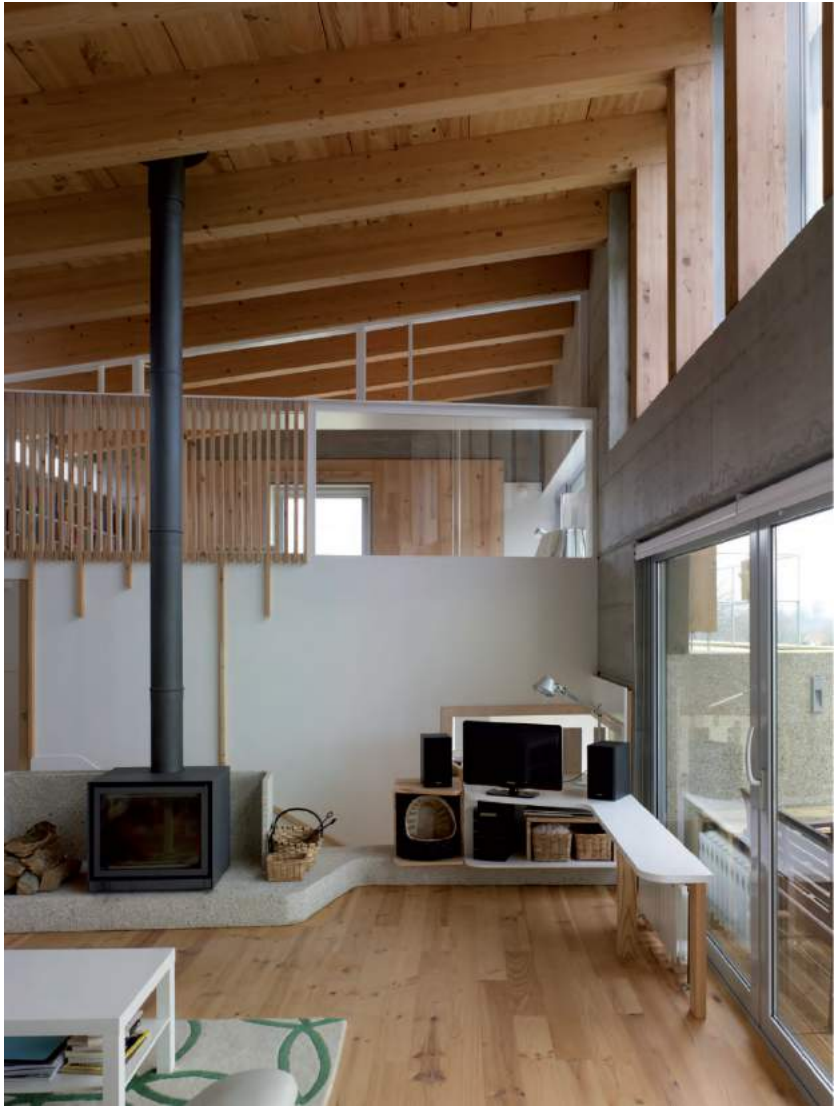
Fig.19. Vivienda unifamiliar en Santiago de Compostela. Ameneiros Rey Arquitectos. 2013. Ejemplo de la incorporación de madera en la vida cotidiana actual. Estructura de cubierta con vigas laminadas de madera de pino, tarima de pino y mobiliario interior también de este tipo de madera.
