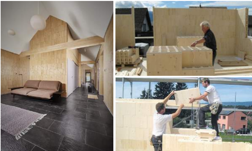
Fig.05. Vivienda unifamiliar en Lucatín, Eslovaquia por Jaro Krobot, 2016. Montaje de los muros y particiones mediante el sistema de piezas modulares o bloques. Se decide dejar vista la cara interior de los muros de cerramiento y particiones interiores.
