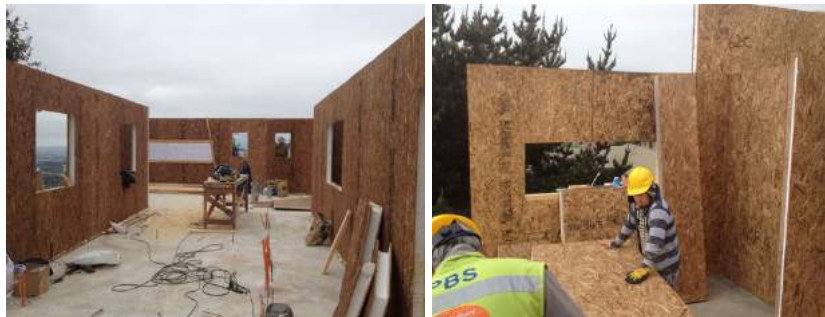
Fig.06. Construcción de vivienda unifamiliar mediante el sistema constructivo de paneles SIP. Cortados y trabajados a pie de obra.
