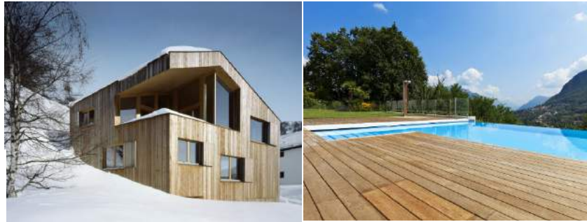
Fig.11. Madera expuesta al uso de clase 4 en dos ambientes opuestos. En la imagen de la izquierda se trata de un revestimiento exterior con madera de roble tratada por autoclave y en el caso de la imagen de la derecha se trata de un pavimento de madera de teca con un tratamiento solamente de barnizado.
