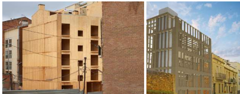
Fig.9 Edificio plurifamiliar en Lleida, España 2015. Hasta ahora el edificio en madera más alto de España. Alberga cinco plantas, 346 m 2 construidos y cumple con los 90 minutos de estabilidad frente al fuego exigidos por la normativa para edificios de más de 22 metros de altura.
