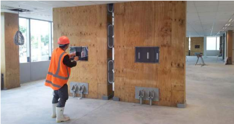
Fig.02. Oficinas en Christchurch, Nueva Zelanda, 2014. Edificio construido mediante el sistema Press-Lam. Formado por nueve muros de LVL armados con seis barras de 50 mm de diámetro cada uno y vigas también de LVL armadas cada una con seis tensores de acero de 15,2mm. Además, este edificio cuenta con la peculiaridad de tener incorporado un sistema de disipación de energía con acero de menor calidad que es fácilmente reemplazable en caso
