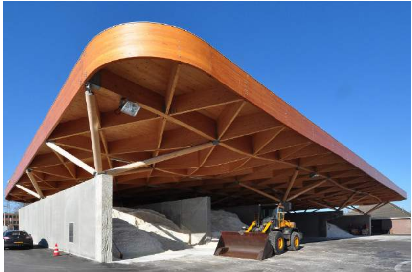
Fig.6 Centro de servicio en Balkendwarsweg, Holanda. Este es solo un ejemplo de arquitectura actual donde se ha logrado disponer una cubierta con luces de hasta 17 metros y sin excesiva sección de pilares. Todo gracias a la elección de la madera como material de construcción.
