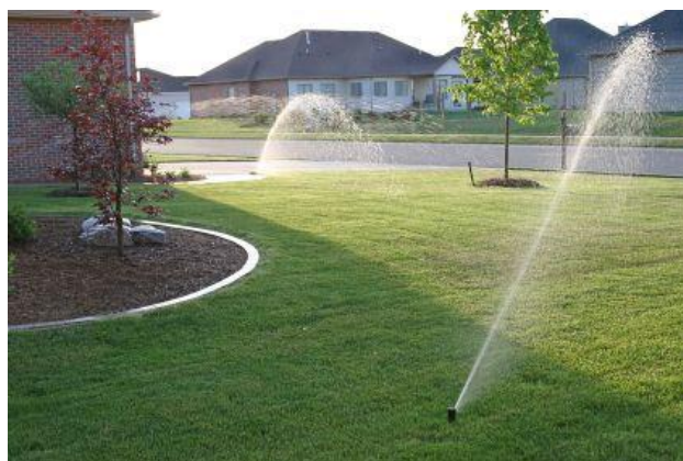
Ilustración 56. Sistema de riego por aspersión
