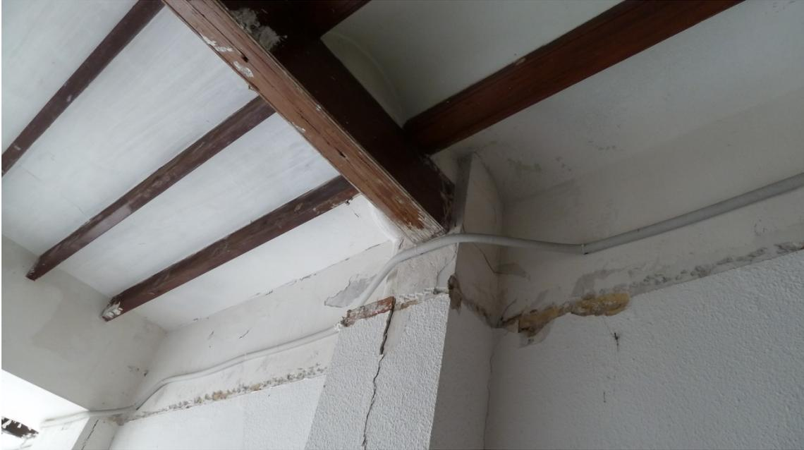
*Figura 158: Fotografía encuentro viga de madera 15x25 con medianera Sur. Fuente propia.*
