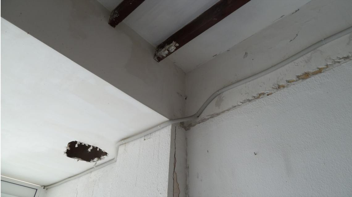
*Figura 160: Fotografía encuentro falso techo con forjado de vigueta de madera y rasilla cerámica. Fuente propia.*
