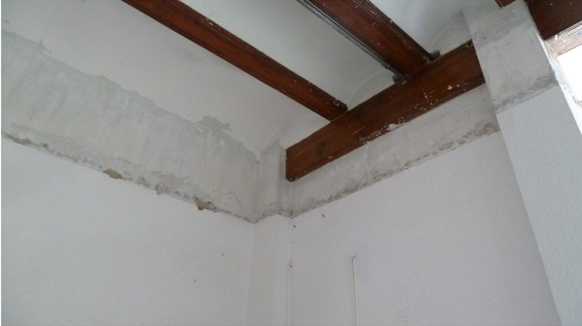
*Figura 156: Fotografía encuentro viga de madera 15x25 con pilar y con medianera Norte. Fuente propia.*
