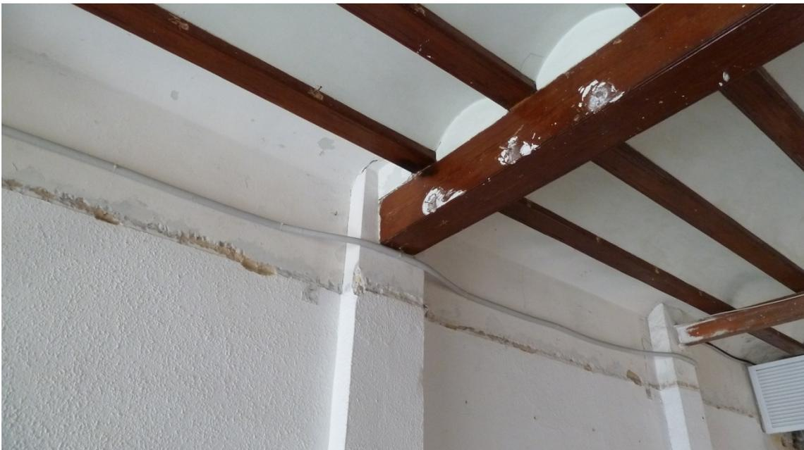
*Figura 153: Fotografía encuentro viga madera de 22x25 con medianera Sur. Fuente propia.*
