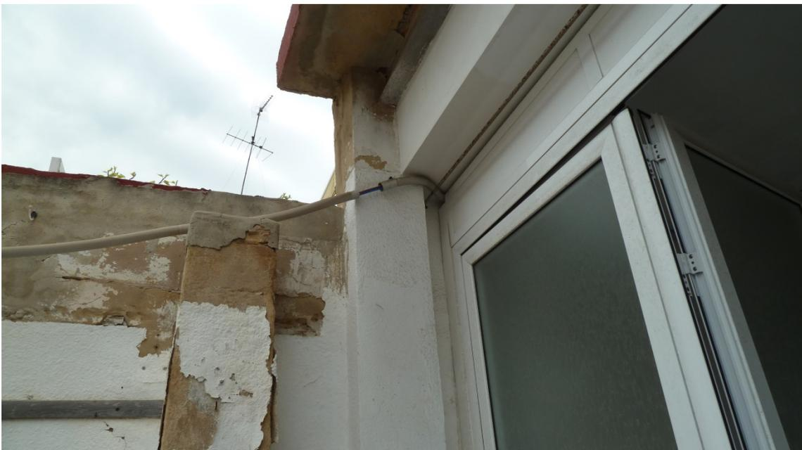
*Figura 161: Fotografía encuentro IPE PN18 con pilastra exterior Sur. Fuente propia.*
