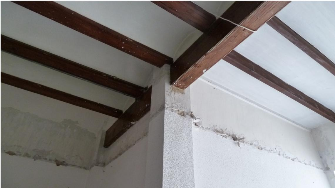
*Figura 157: Fotografía encuentro viga de madera 15x25 con pilar y con medianera Norte. Fuente propia.*
