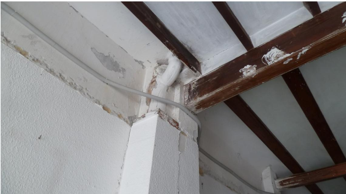
*Figura 159: Fotografía encuentro viga de madera 15x25 con medianera Sur y cajeadado bajante. Fuente propia.*
