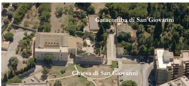
Figura 3. Ambiente urbano in cui si inserisce il complesso di San Giovanni a Siracusa
