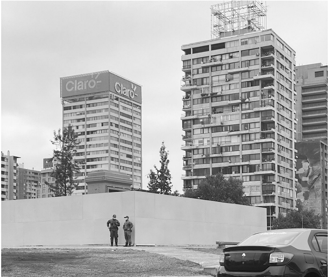
Fig. 130 Levantamiento de muro perimetral en torno a la base del monumento del General Baquedano (2021).
