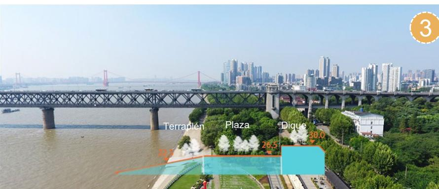
En la orilla opuesta, la playa del río Wuchang tiene un ancho total de 60-80 metros, incluida una presa, con una altura de 30 metros y un ancho de plataforma de 40 metros. Está plantada con plantas resistentes al agua como sauces y álamos, y la pendiente es de 30 grados, que es relativamente suave.
