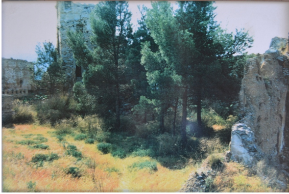
Patio de armas antes de la restauración. Imagen expuesta en el Castillo
