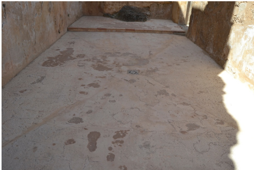
Estado actual del suelo de la capilla
