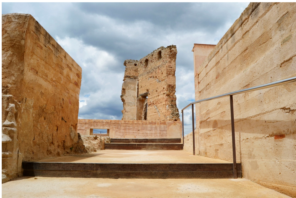
Vista del patio de armas desde la entrada
