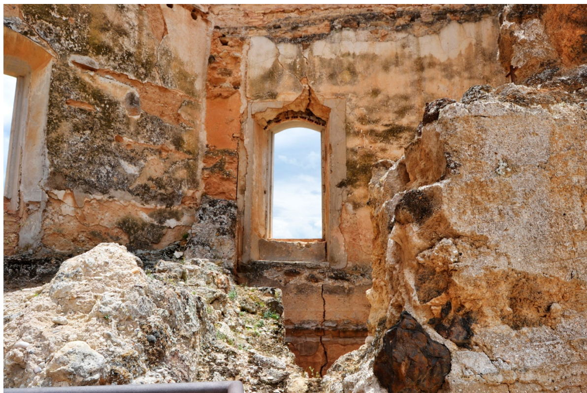
Detalle de muro de tapia de mortero de cal reforzado
