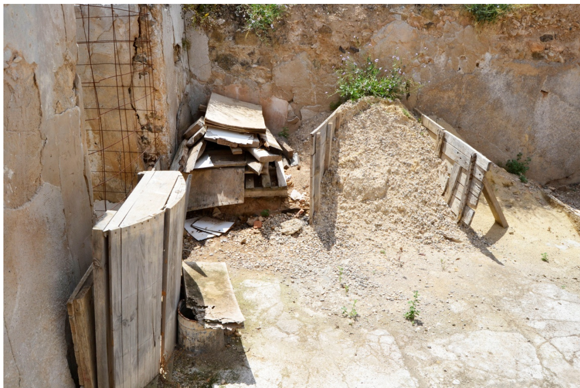
Tapial y encofrado curvo de madera
