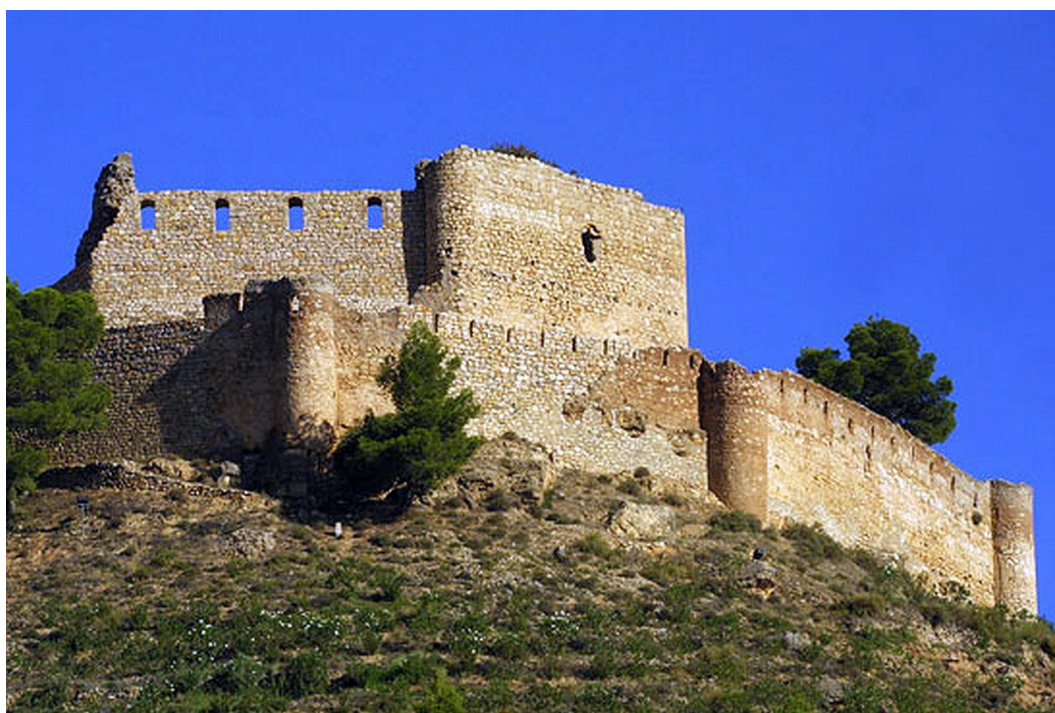
Vista Norte del castillo de Jalance
