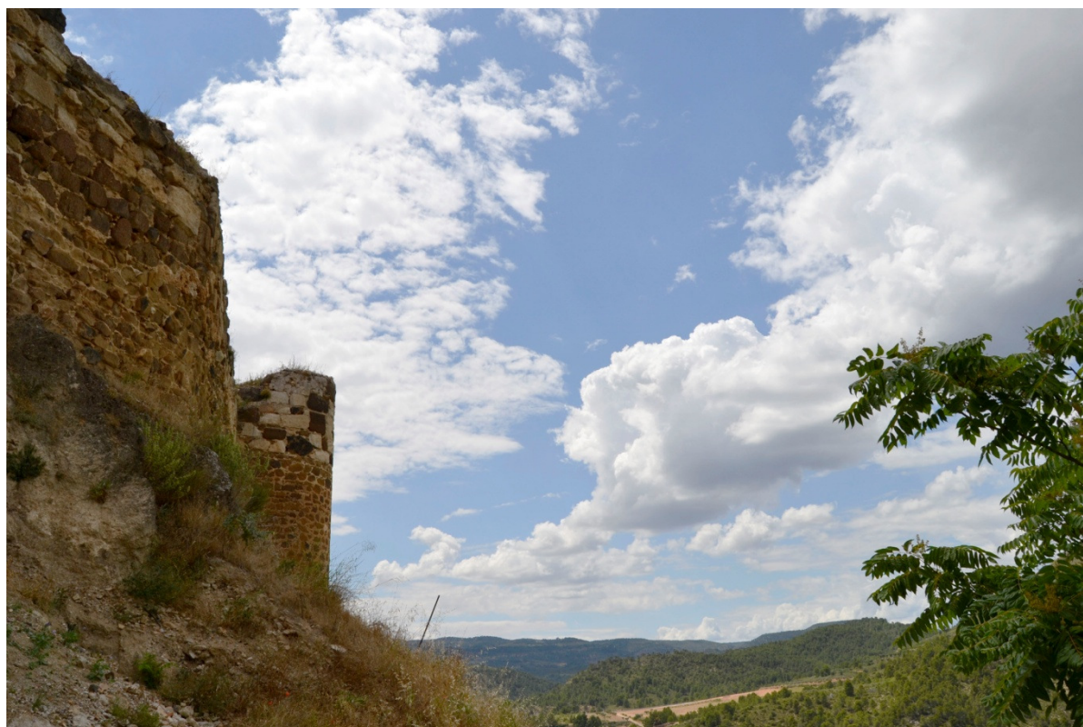
Torreón de la parte Sur del Castillo
