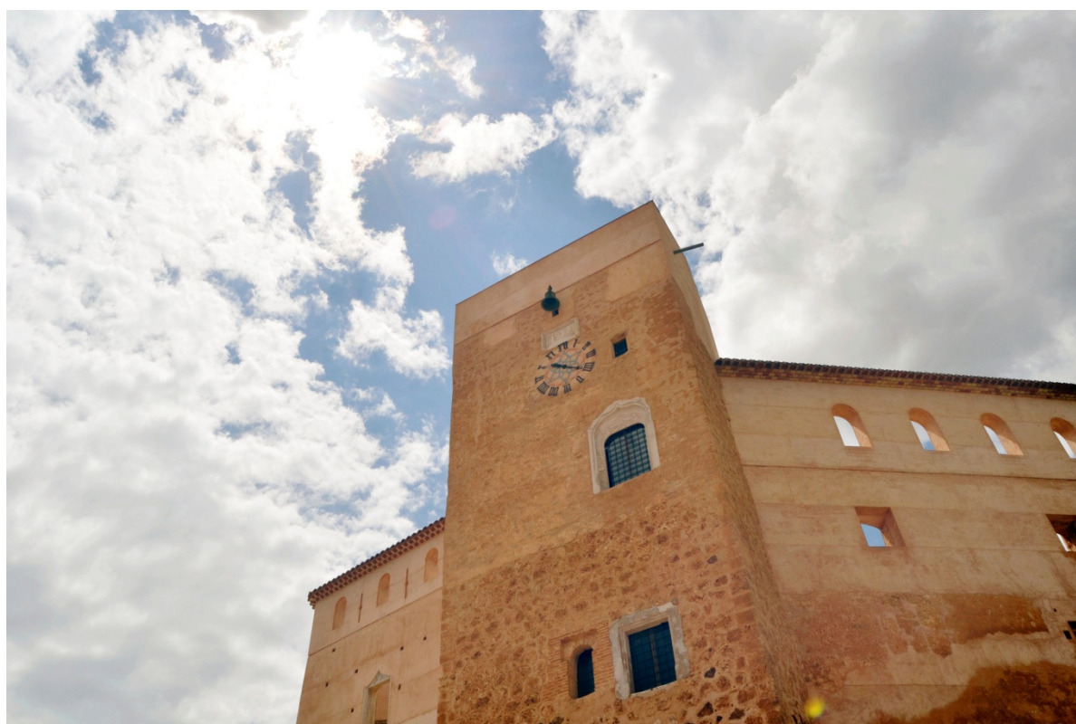
Parte Oeste de la torre del homenaje
