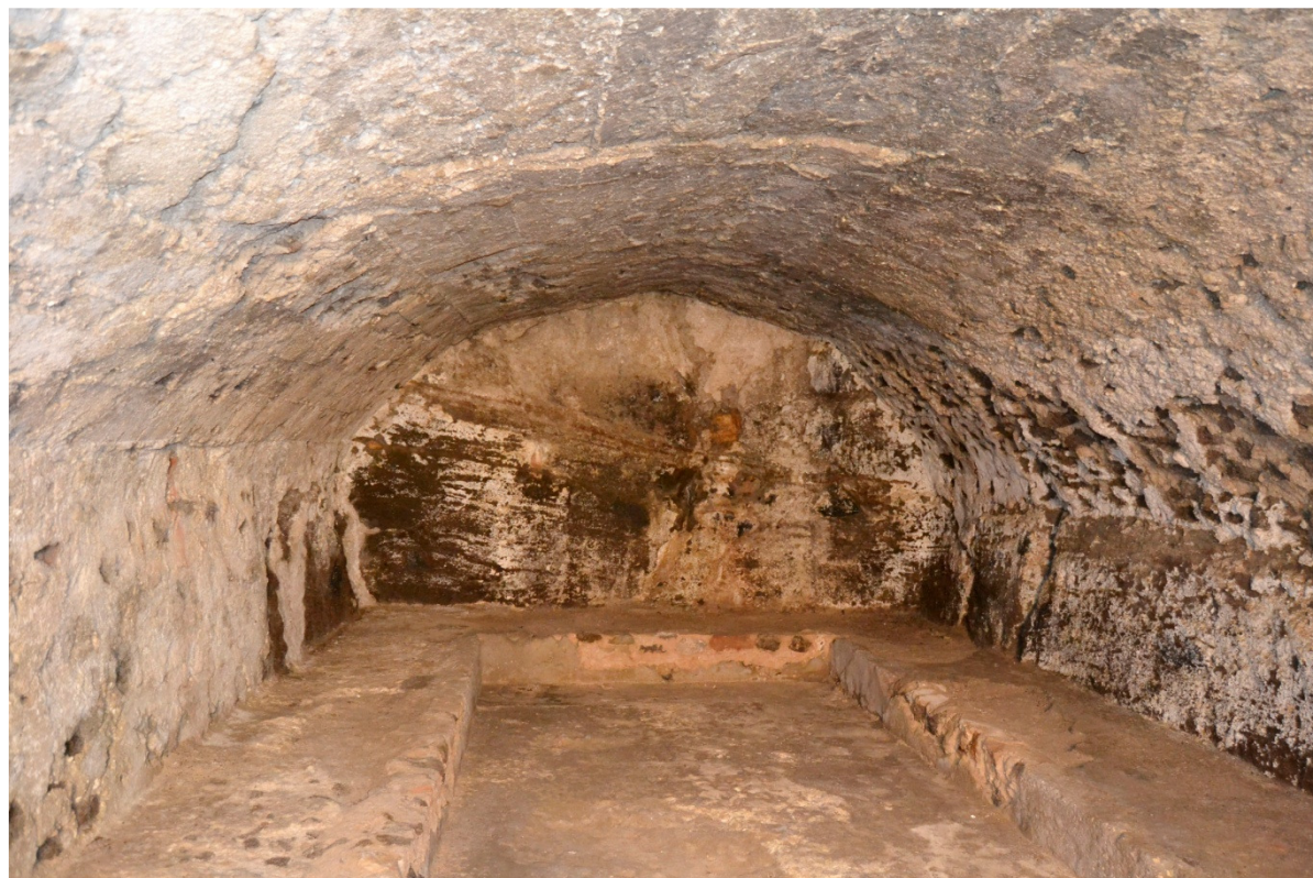
Antigua despensa bodega. Espacio bajo la zona de dormitorios
