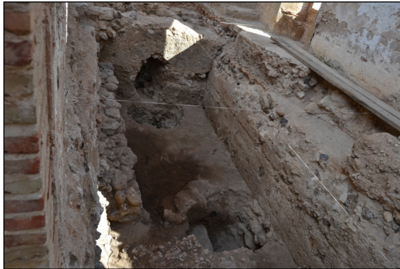
Imagen del estado actual de la sala 05
