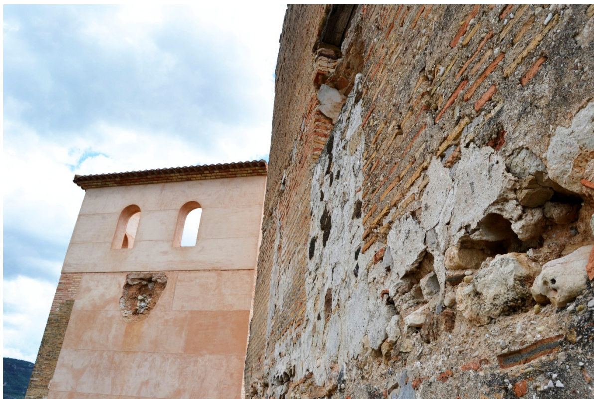
Zona exterior Dormitorios y sala 05 mirando hacia el Oeste
