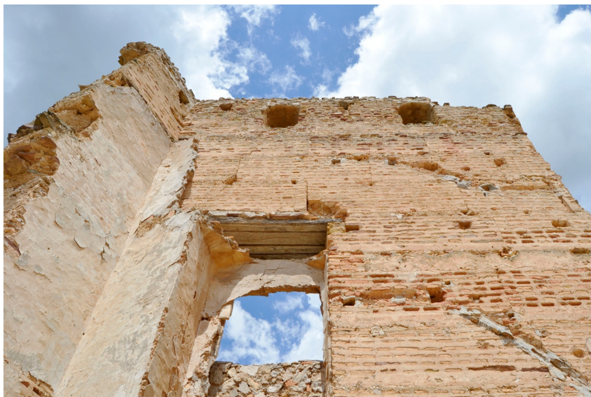
Muro original de tapia valenciana con dintel de madera
