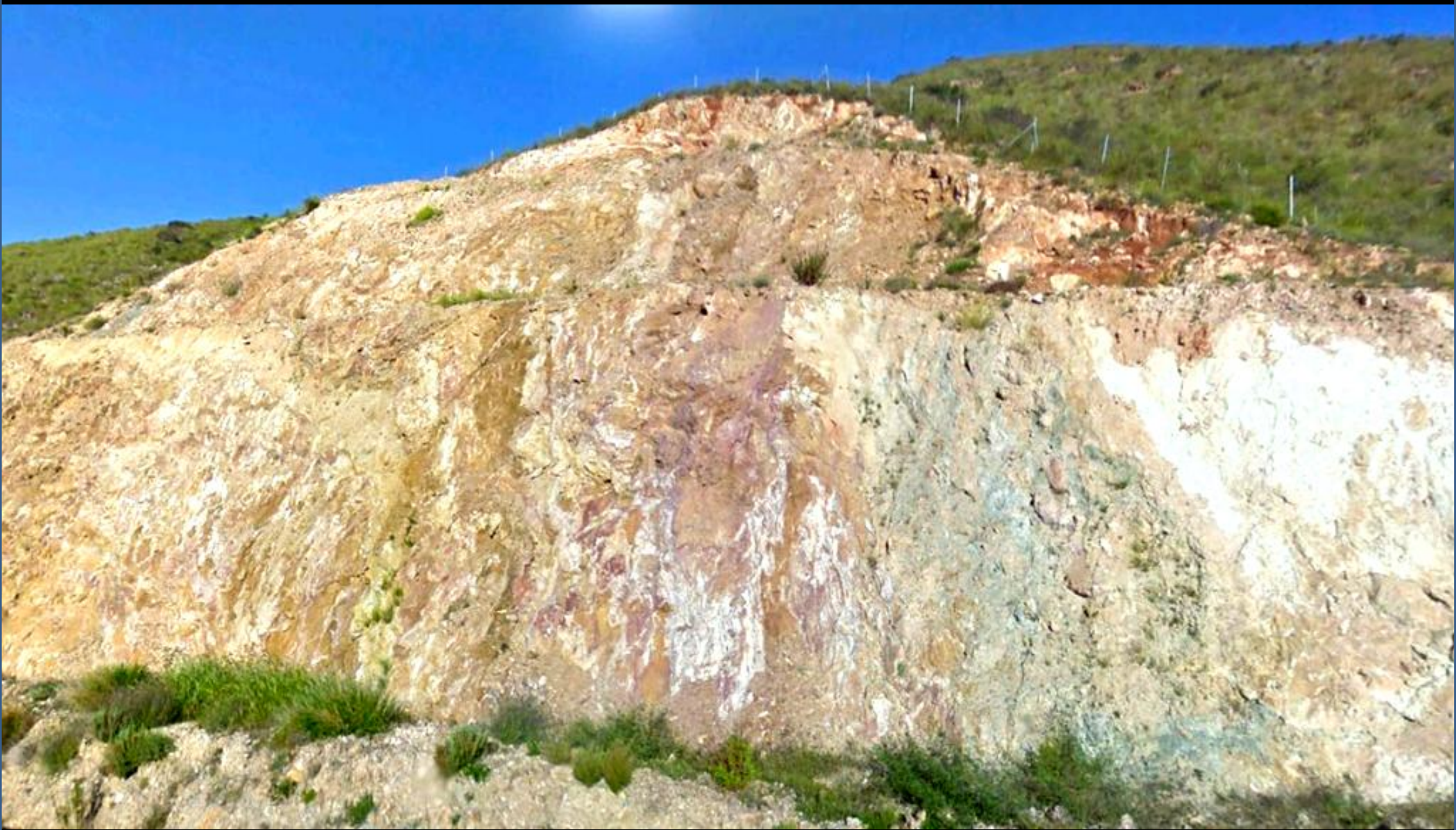
Triásicos en zona de cabalgamiento. Talud en la Autopista del Mediterráneo. NE -Hoja- de Mazarrón. Murcia.
