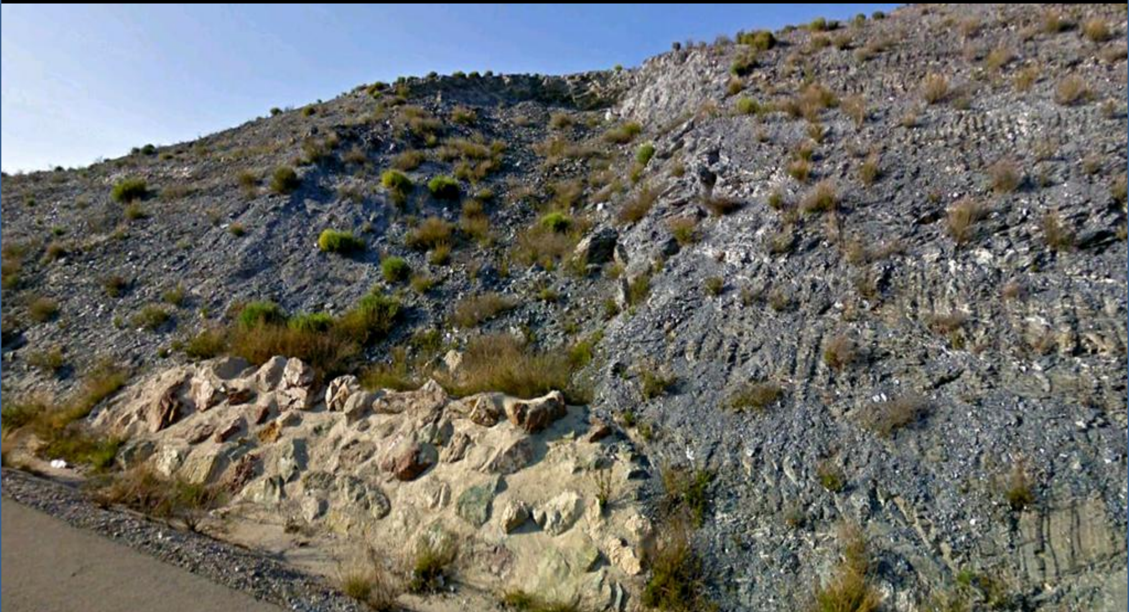
Actuación tras el deslizamiento en cuña entre las filitas, cuarcitas y pizarras Permo-Triásicas tectonizadas. SE de Las Norias, NE Hoja de Velez Rubio. Murcia.
