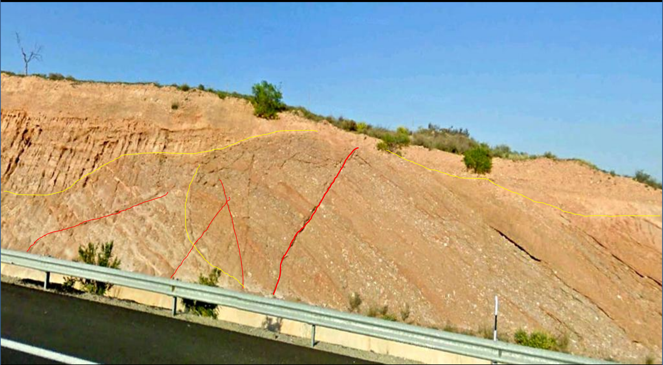
Fallas y discordancias en los conglomerados, areniscas y arcillas del Tortonense, Mioceno, Terciario. N de Puerto Lumbreras. SW Hoja.
