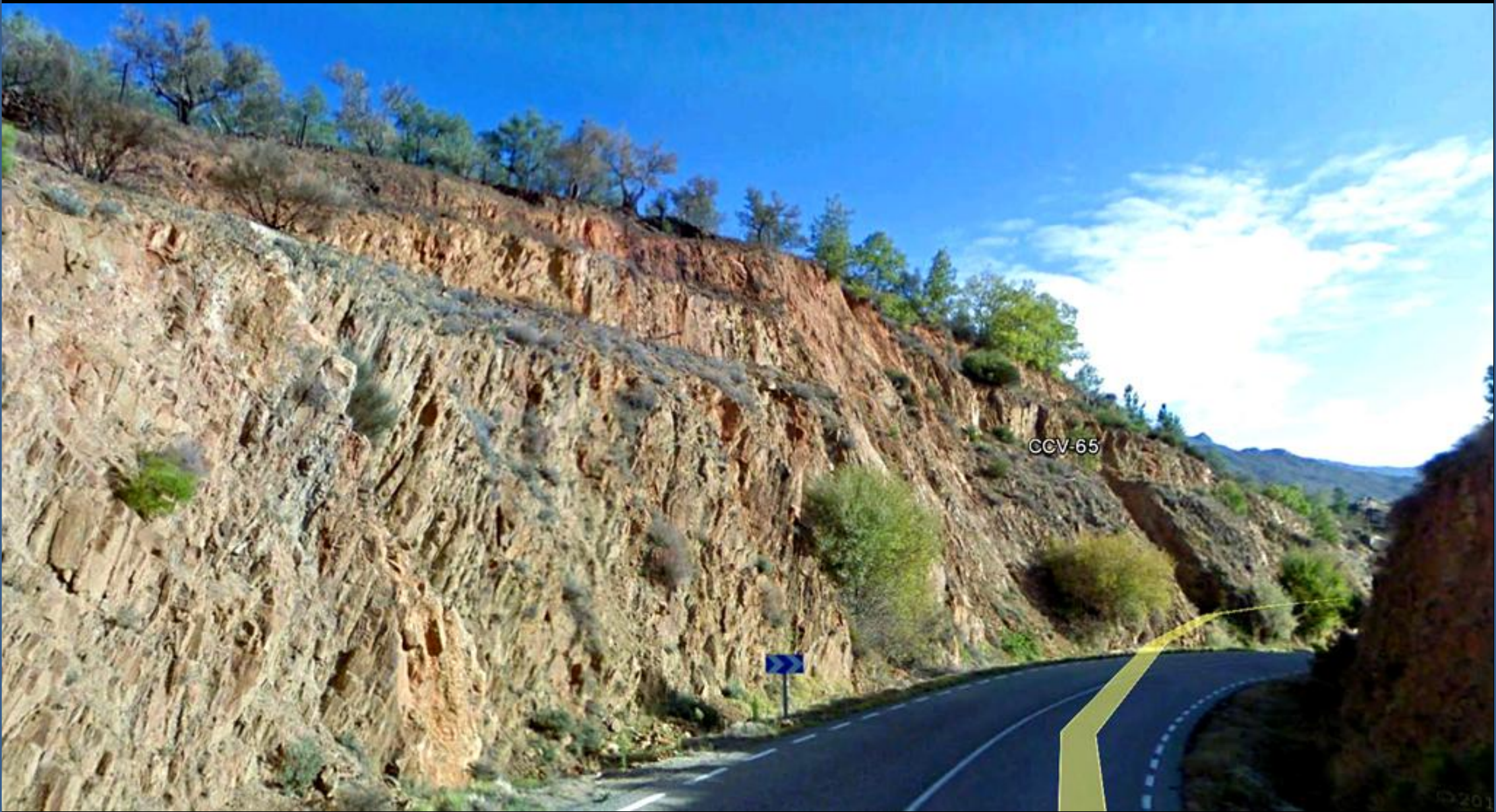
Taludes en zona de esquistos y metapelitas del contacto metamórfico. E Hoja – N de Valverde del Fresno, Cáceres.
