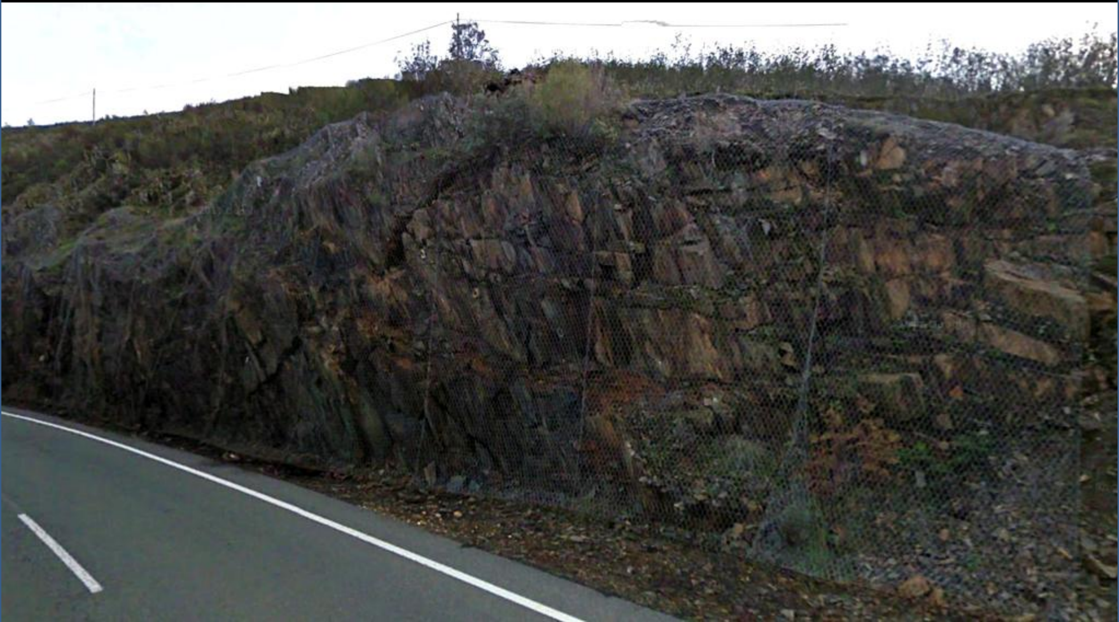
Mallazo en talud de pizarras y grauvacas del Cámbrico Inf. S de Revollosa . NE de Cáceres. SE Hoja de Miranda del Castañar.
