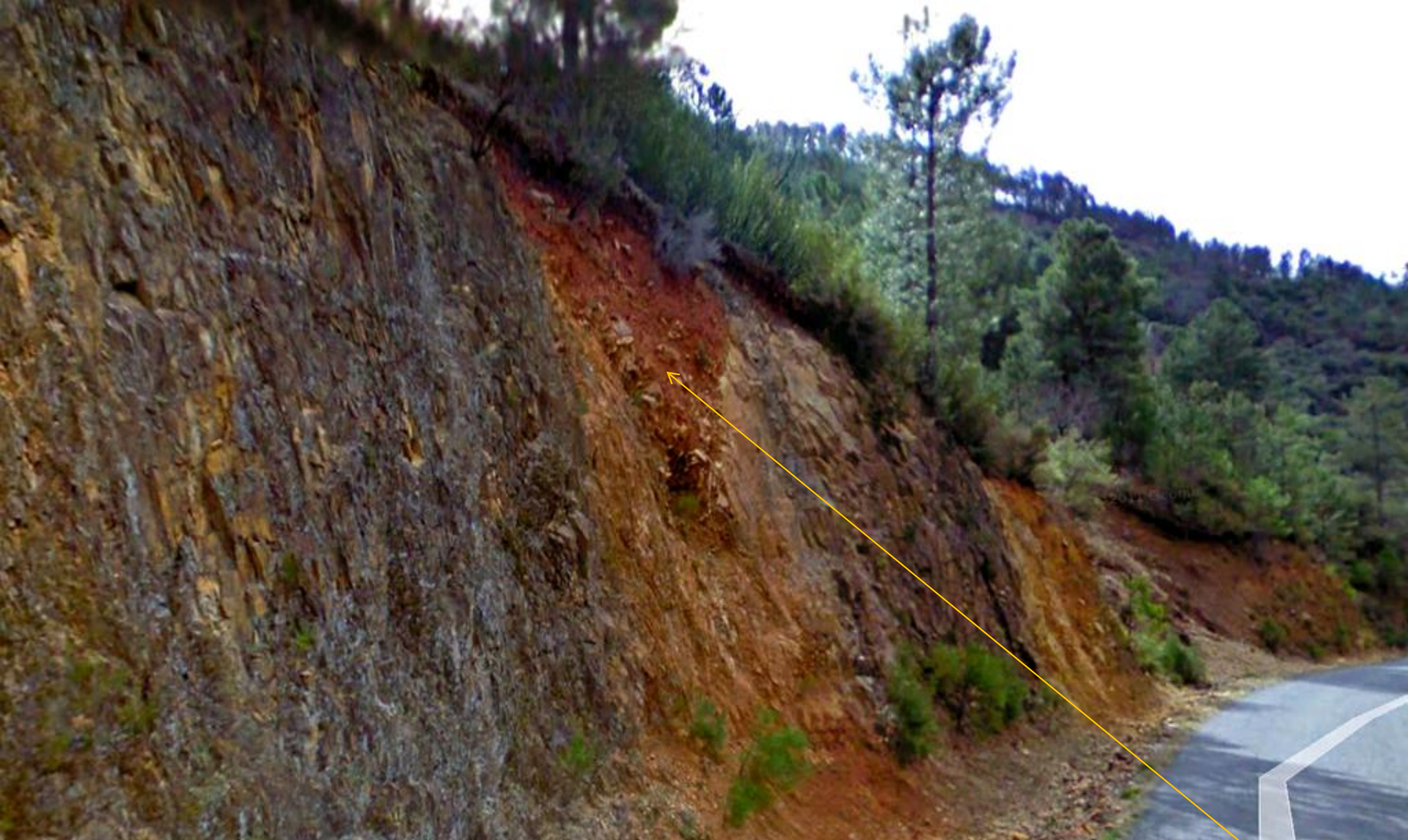
Talud en las pizarras del Precámbrico Sup., y rellenos de depósitos de ladera, rojizos, en el Collado de La Mudás, SE de Las Erías, Sierra de Gata, Cáceres. SW Hoja de Martiago.
