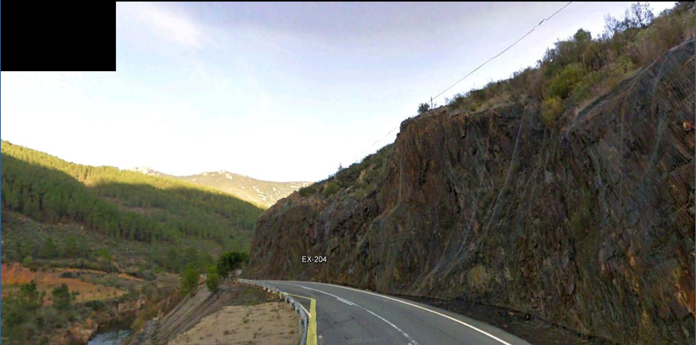
Mallazo en talud de pizarras del Cámbrico Inf. NW de Riomalo de Abajo. NE de Cáceres. SE Hoja de Miranda del Castañar.
