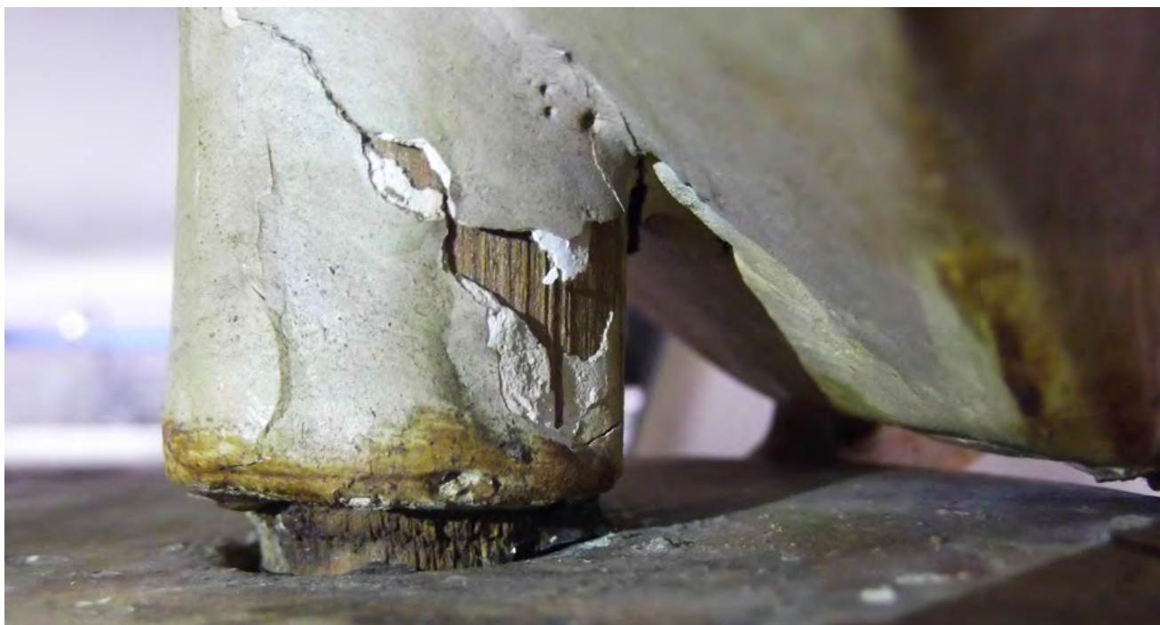
Ilustración 4 Detalle de la grieta junto con la pérdida de preparación y película pictórica, dejando a la vista el soporte de madera.
