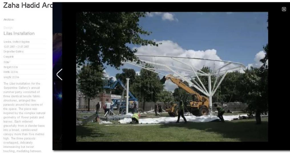
Fig.50 - proceso de instalación de la obra de arquitectura efímera *Lilas Installation* de Zaha Hadid
