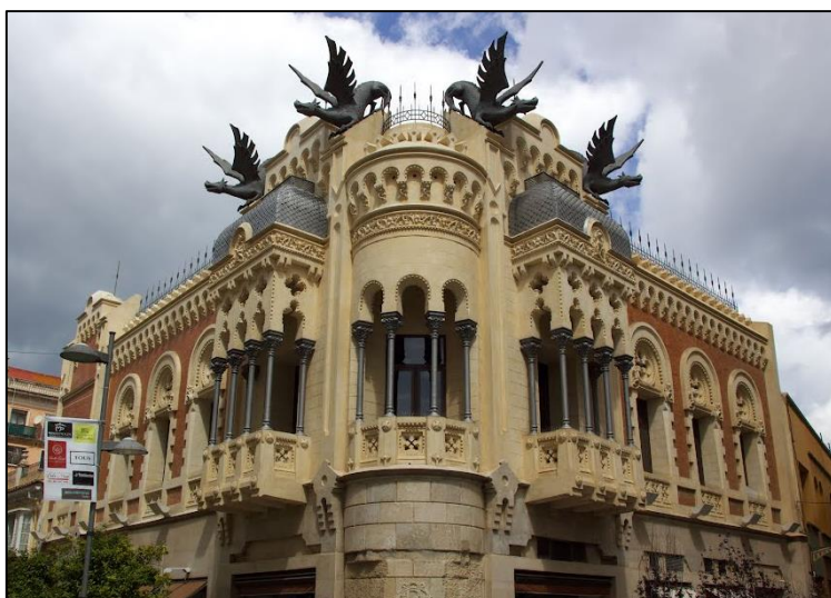
Ilustración 27: Casa de los dragones en Ceuta. Fuente: Google Imágenes. 2016.
