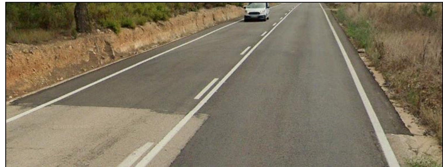
Imagen 25. Reparación de un tramo de la calzada. Fuente: Google Earth
