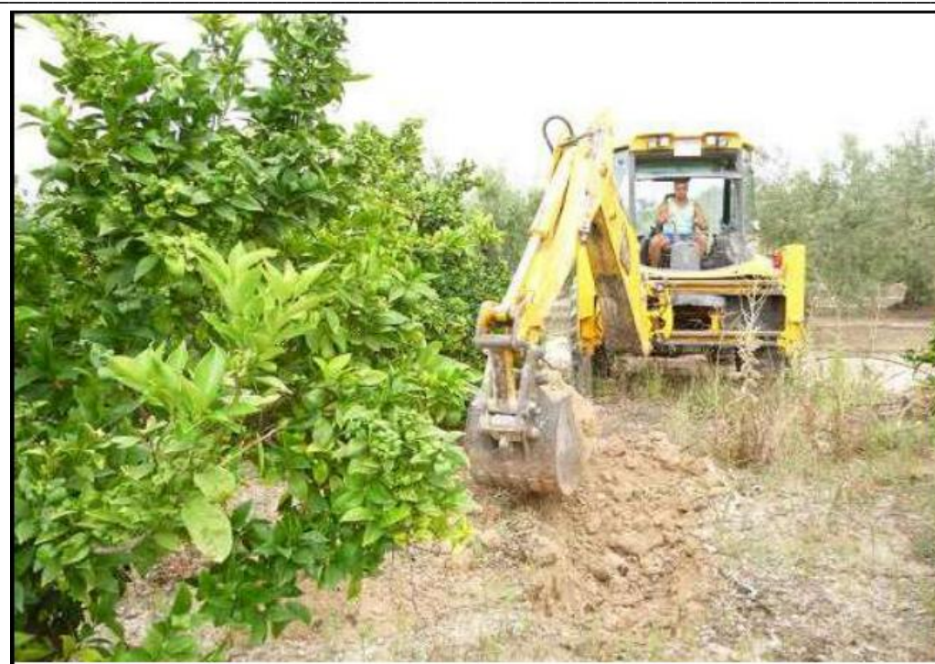
Figura 9. Acopio y emplazamiento de la excavación. Fuente: Ensayo Intercontrol Levante
