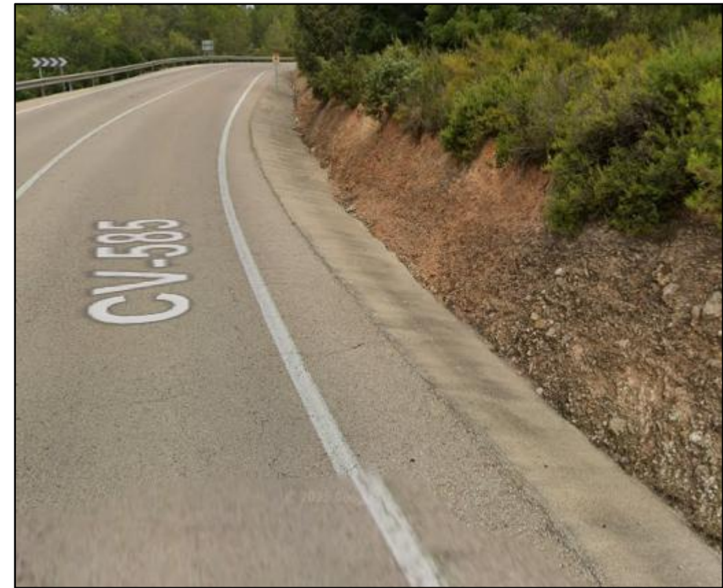
Figura 18. Drenaje longitudinal revestido en el P.K. 2+480. Fuente: Elaboración propia
