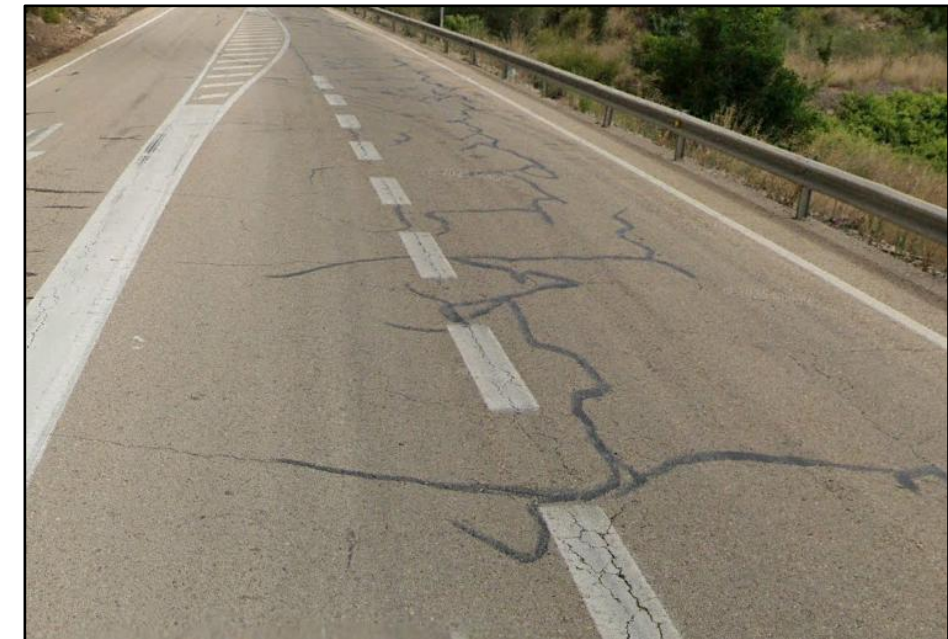
Imagen 20. Sellado de grietas. Fuente: Google Earth
