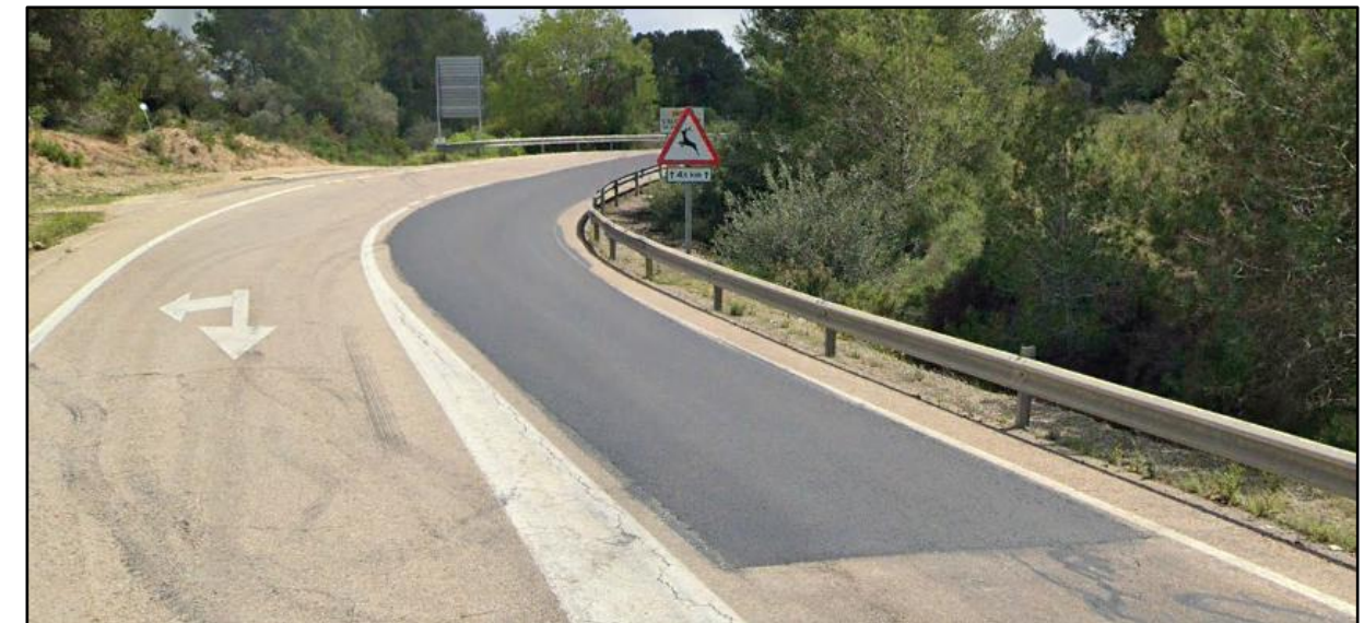
Imagen 21. Parche en caliente. Fuente: Google Earth
