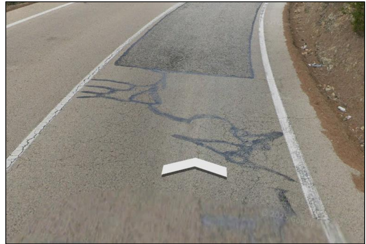
Imagen 24. Sellado de grietas y parche en frío. Fuente: Google Earth
