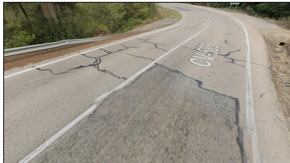
Figura 6. Sellado de grietas. Fuente: Google Maps
