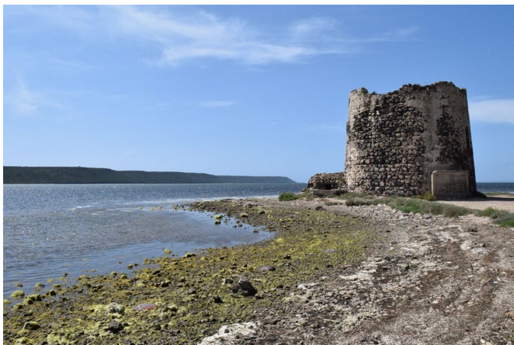
Fig. 16- Torre Marceddi (ca. 1580) en Terralba, que cuenta con un búnker anexo de hormigón armado camuflado por el recubrimiento de piedras, ca. 1942-1943, Cerdeña, Italia (autor 2015).
