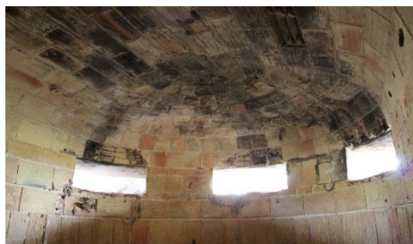
Fig. 13- Interior de un búnker con encofrado de ladrillo para el hormigón en Balsares, ca. 1937-1938, España (autor 2014).
