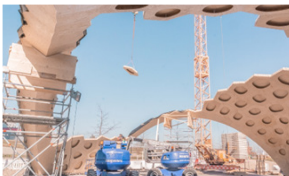
Figura 42. Proceso montaje Wood Pavilion 2019
