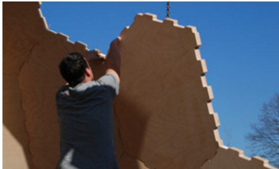
Figura 37. Detalle juntas pabellón Expo 2014
