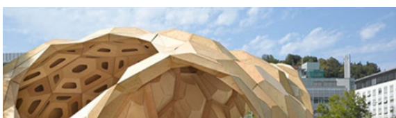
Figura 34. Vista exterior cubierta, Research Pavilion 2011
