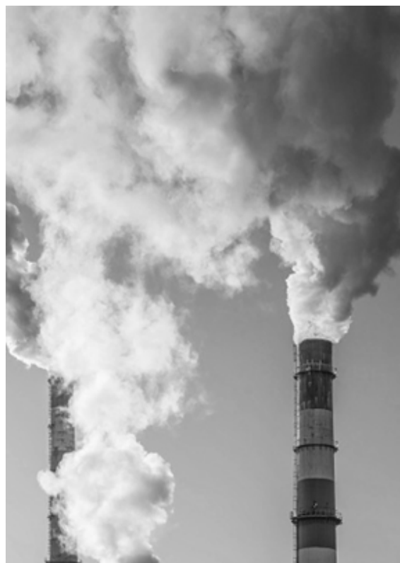
Figura 59. Imagen chimeneas industriales
