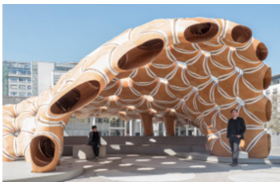
Figura 38. Imagen exterior Research Pavilion 2016
